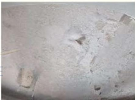
Foto. n.°81 – Umidità soffitto vano 1
