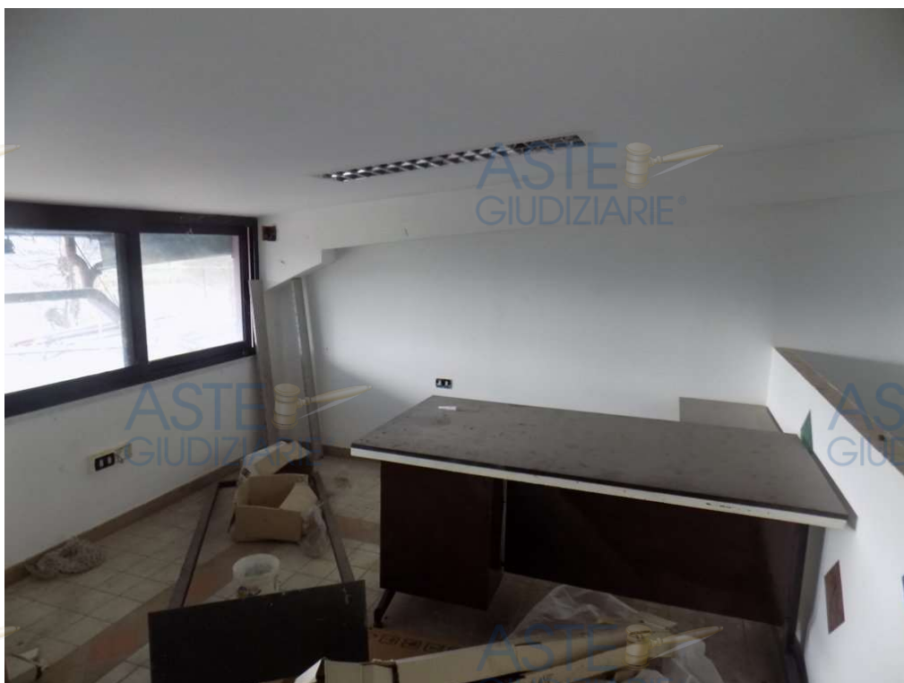
Fig. 20: Particolare degli interni della zona soppalcata alla quale si accede dalla parte centrale del capannone (show room)
