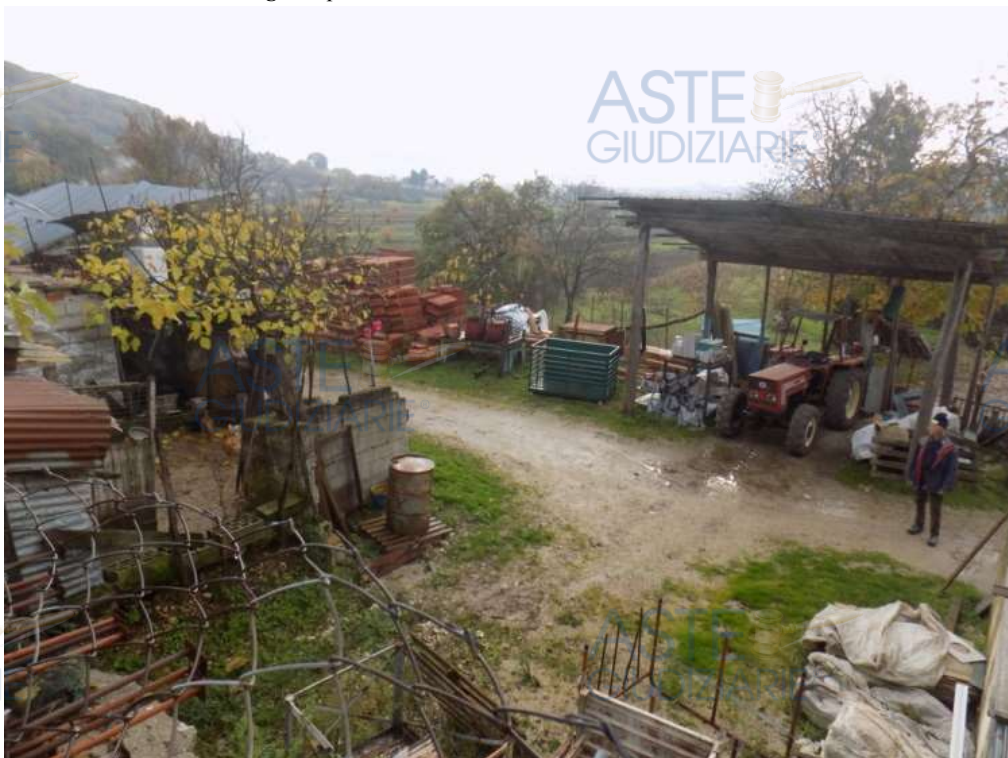
Fig. 13: Terreno Part. 208 (di pertinenza del capannone part 207, attualmente utilizzato come deposito materiali edili) su cui insiste servitù di passaggio pedonale e carrabile a beneficio della part. 206 non eseguita
