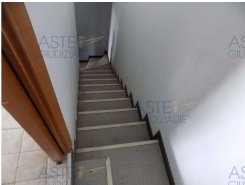
Fig. 17: scala di accesso alla zona soppalcata nella zona centrale del capannone (show room)
