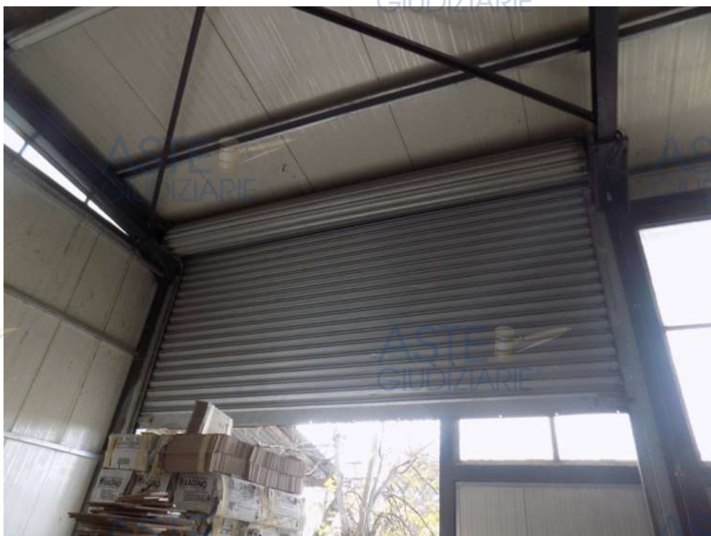
Fig. 19: Particolare della struttura e delle chiusure perimerali del capannone, apribili e non.
