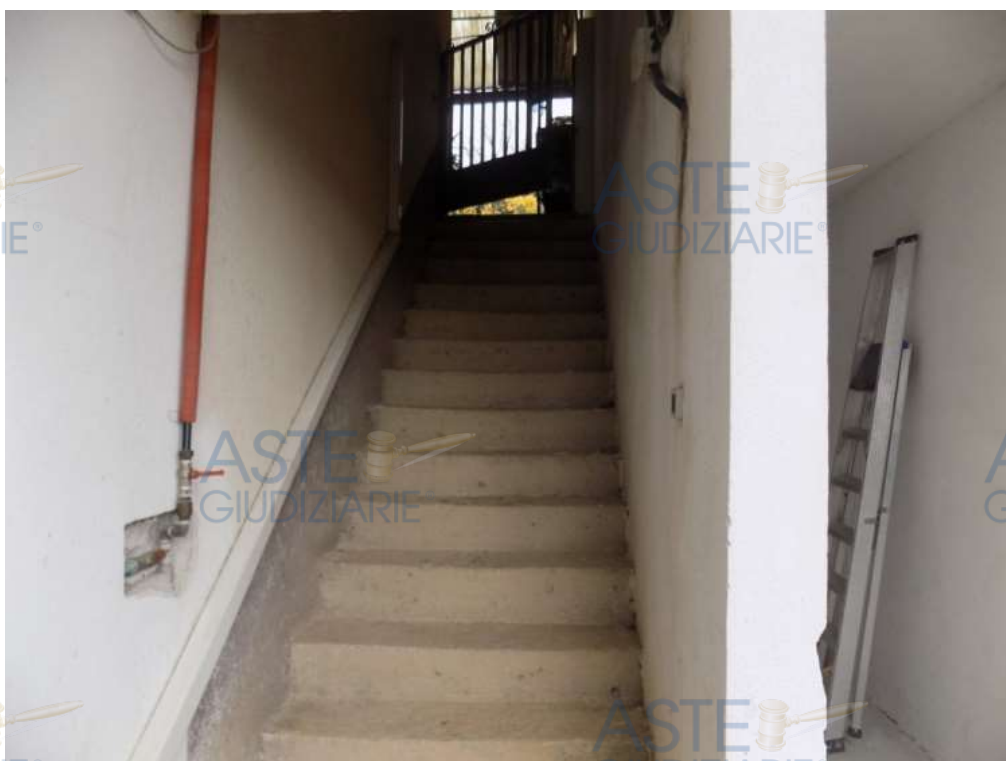
Fig. 11: Scaletta pedonale posta al lato sinistro dell'edificio, che conduce al deposito lato est attualmente in uso come autorimessa
