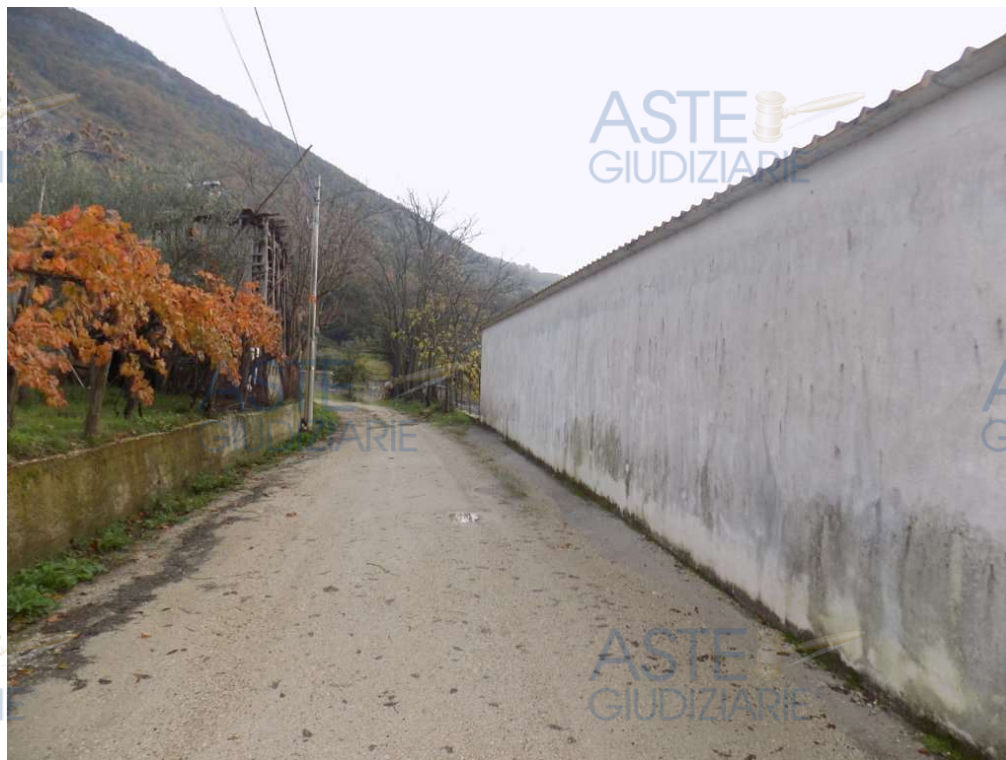
Fig. 2: Particolare del prospetto posteriore (lato nord del capannone part. 207), confinante con strada vicinale di uso pubblico in parte sterrata
