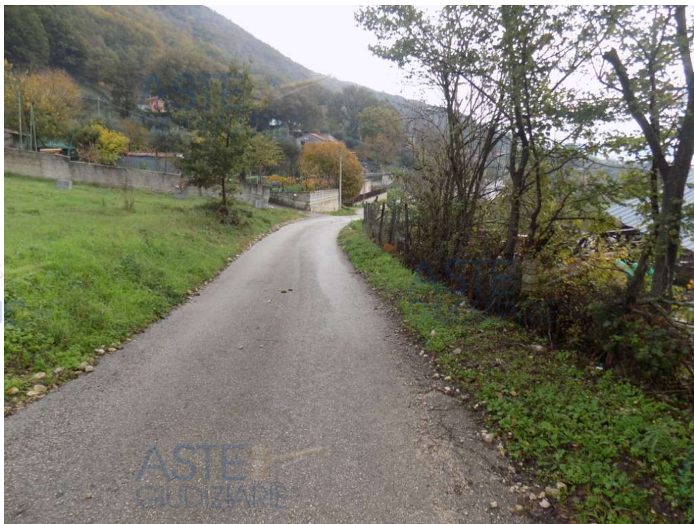
Fig. 1: strada comunale di accesso al lotto unico, che lambisce il terreno Part. 208
