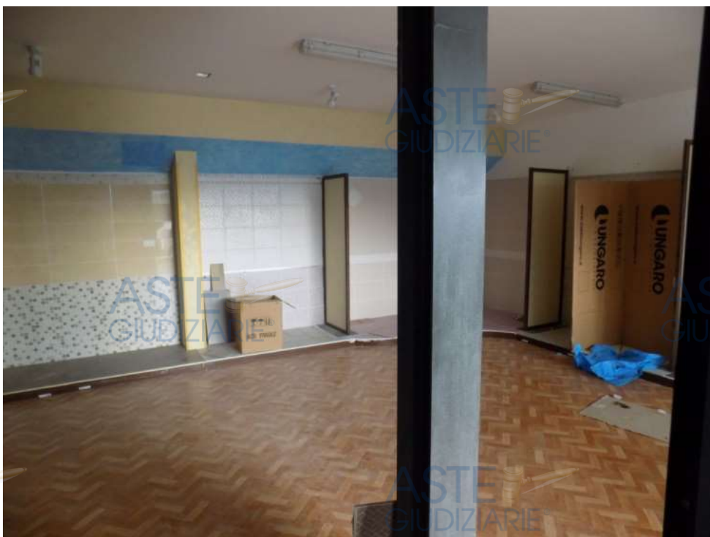
Fig. 18: Particolare degli interni del capannone ad uso commerciale (zona show room)
