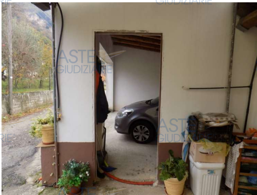
Fig. 27: Particolare dell'autorimessa (accesso laterale non assentito)
