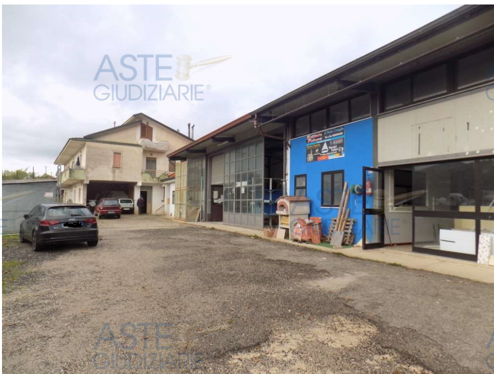
Fig 5: area per l'accesso e la sosta temporanea, utilizzata anche dai residenti dell'abitazione adiacente part. 206 estranea alla presente esecuzione e di proprietà terza
