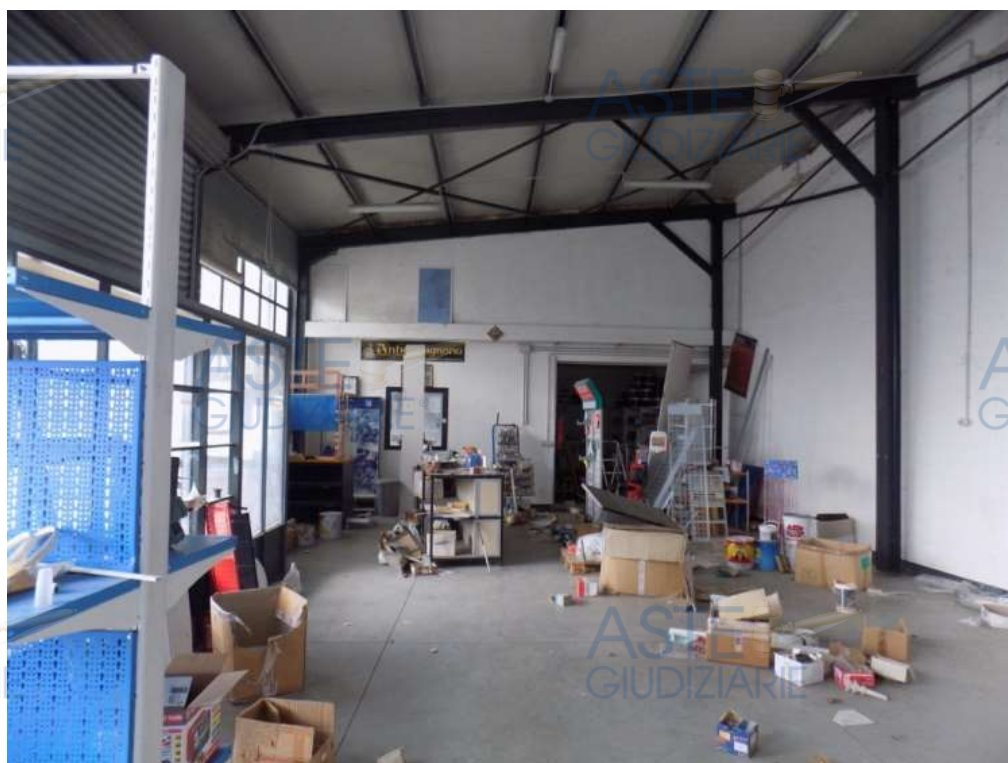
Fig. 16: Particolare degli interni del capannone ad uso commerciale (zona vendita posta nella porzione di estrema sinistra)
