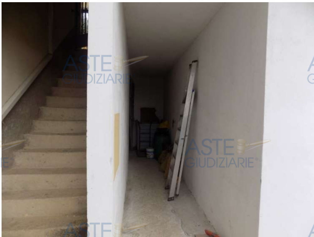
Fig. 10: vano deposito esterno, sito a sinistra del piano terra, posto tra l'ingresso del capannone e la scaletta pedonale comune
