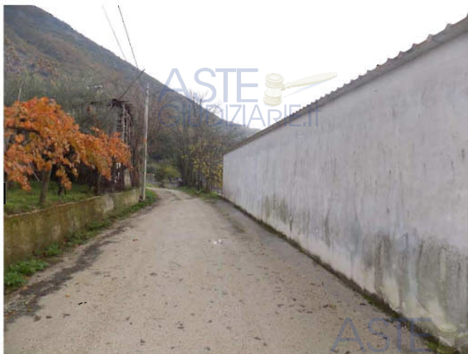
Particolare del prospetto posteriore (lato nord del capannone part. 207), confinante con strada vicinale di uso pubblico in parte sterrata.
