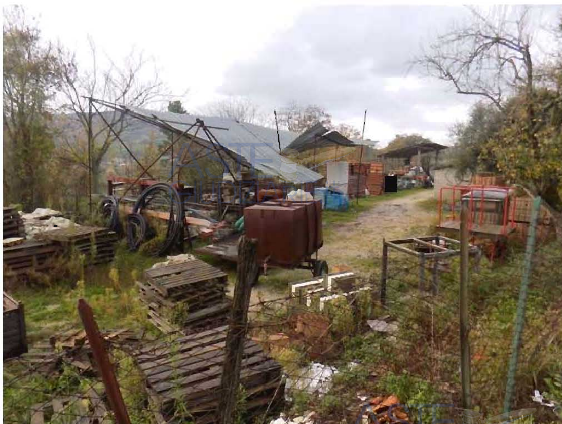
Terreno Part. 208 (di pertinenza esclusiva del capannone part 207, attualmente utilizzato come deposito materiali edili) su cui insiste servitù di passaggio pedonale e carrabile a beneficio della part. 206 non esecutata.
