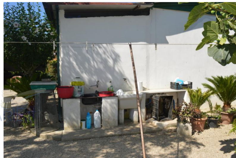
Figura 12: prospetto Nord-Est del prefabbricato. Si notino in particolare il lavello e il lavatoio sorretti da spallette in muratura finite al grezzo.
