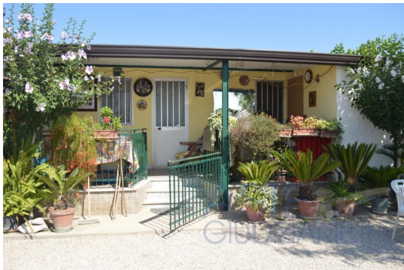
Figura 5: prospetto frontale del prefabbricato abusivo posizionato sulla part. di terreno 530.
