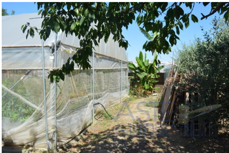
Figura 33: impianto serricolo visto dal confine con la strada interpoderale.
