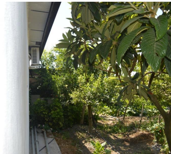
Figura 26: prospetto Sud-Ovest del prefabbricato abusivo.
