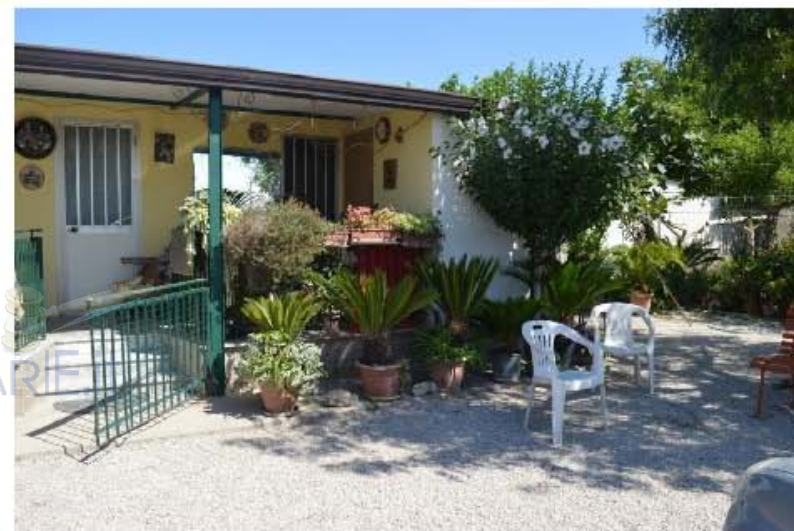
Figura 8: ulteriore visione del prefabbricato a dibito a d abitazione con terreno circostante.
