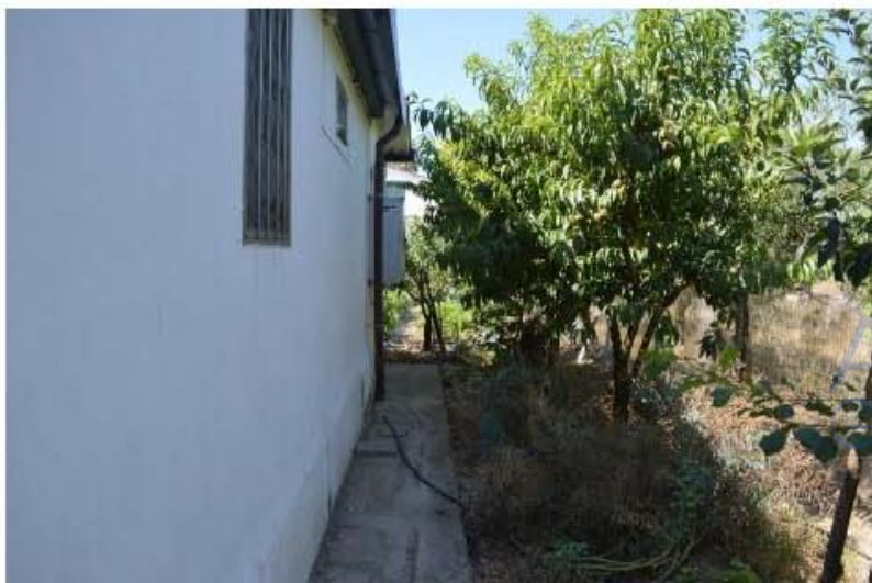
Figura 11: prospetto Nord della struttura prefabbricata abusiva. Si noti la caldaia apposta sulla facciata.
