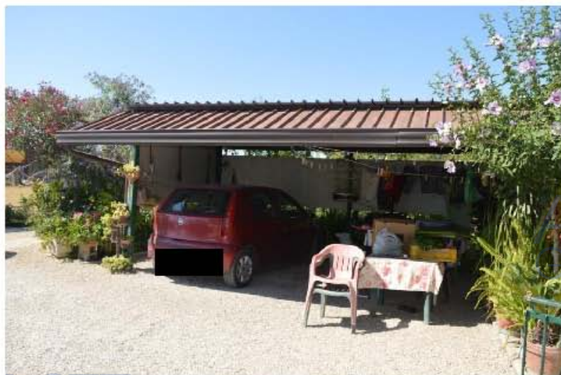
Figura 7: tettoia adibita a parcheggio auto. Struttura in alluminio e tettoia in lamiera, completa di grondaia e pluviali.
