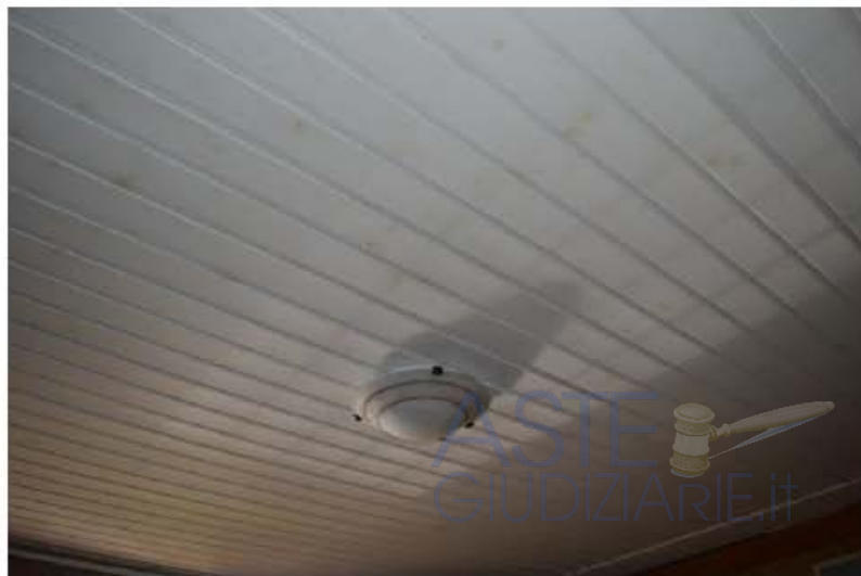
Figura 25: particolare dell'illuminazione artificiale e del soffitto in materiale ligneo.
