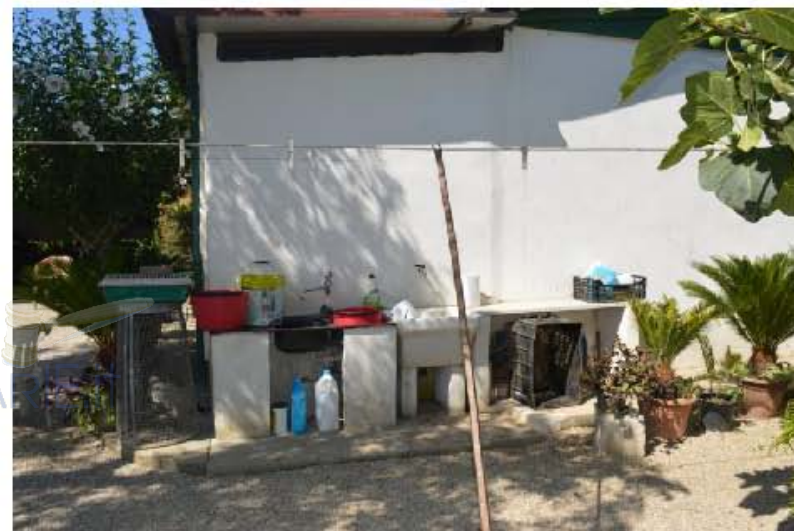
Figura 12: prospetto Nord-Est del prefabbricato. Si nota in particolare il lavello e il lavatoio sorretti da spallate in muratura finite al grezzo.
