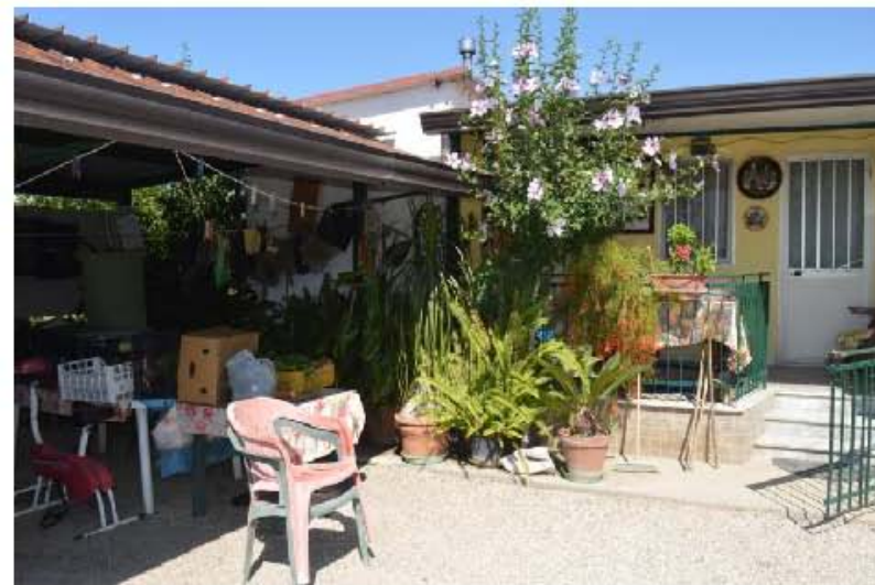
Figura 6: particolare della tettoia destinata al posto macchina, affiancata al prefabbricato.
