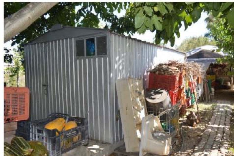
Figura 30: deposito 2, struttura in lamiera e alluminio. Non censito.
