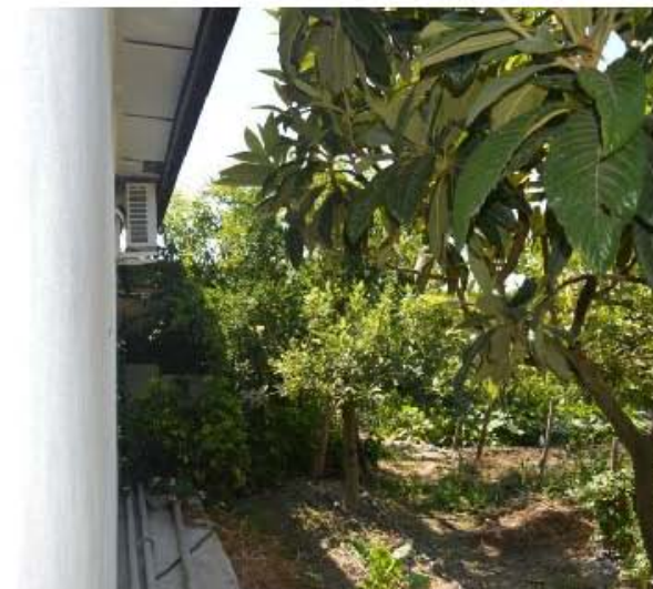
Figura 26: prospetto Sud-Ovest del prefabbricato abusivo.
