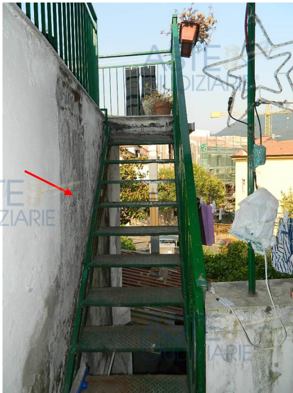
Foto 46 e 47: Scala esterna in ferro che conduce al livello dal quale è possibile accedere al sottotetto grezzo, ripresa da due angolazioni contrapposte, rispettivamente. Si notino le murature da mantenere.
