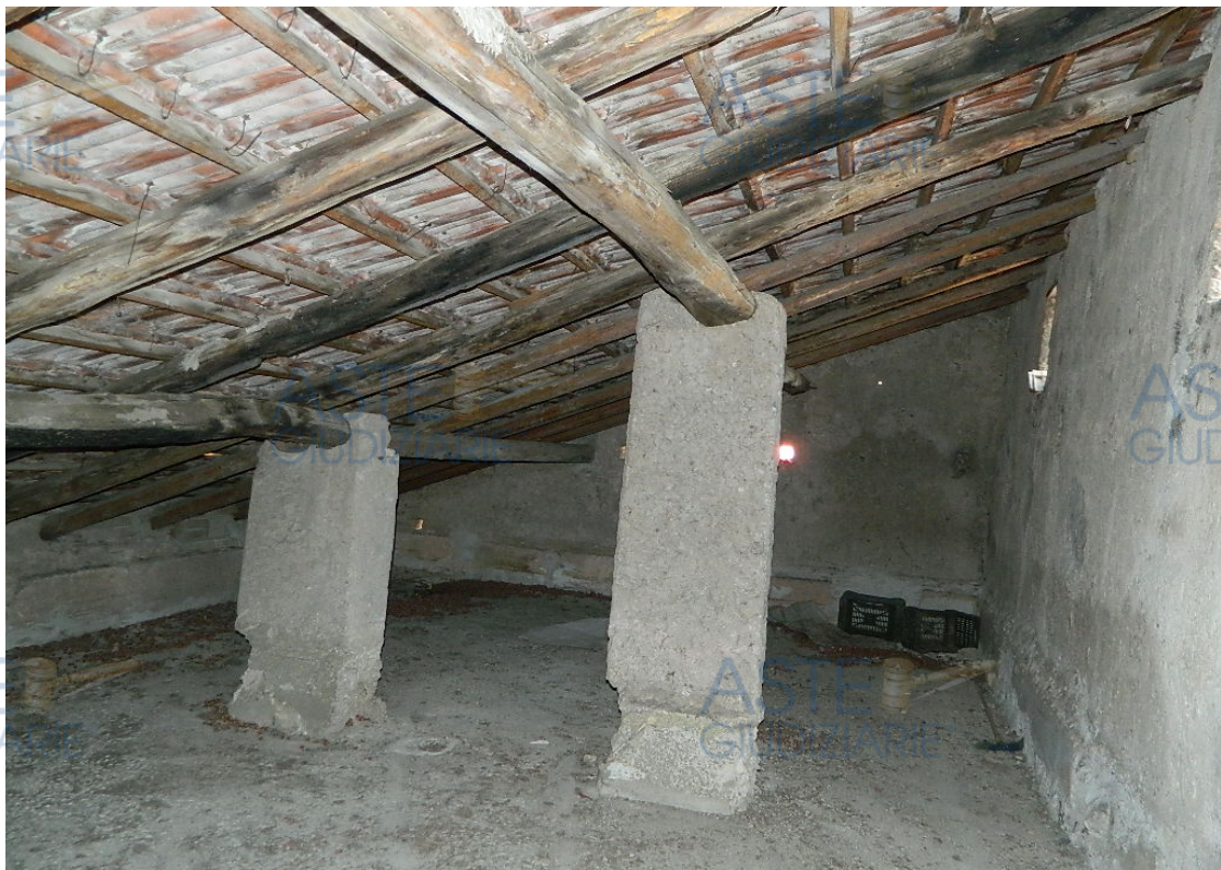
Foto 50: Altra vista del sottotetto con particolari delle strutture verticali e del copertura a falde inclinate, con orditure principale e secondaria in legno, e manto di copertura con tegole di laterizio.
