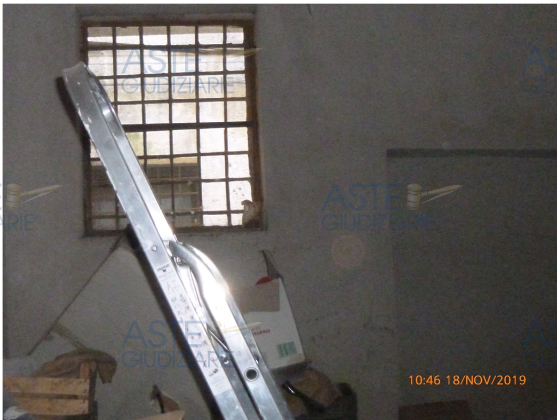
Foto 53: Locale del locale deposito ubicato in adiacenza all'androne, dotato di sopraluca ubicato sulla via Giudice Mattei, lato Est.
