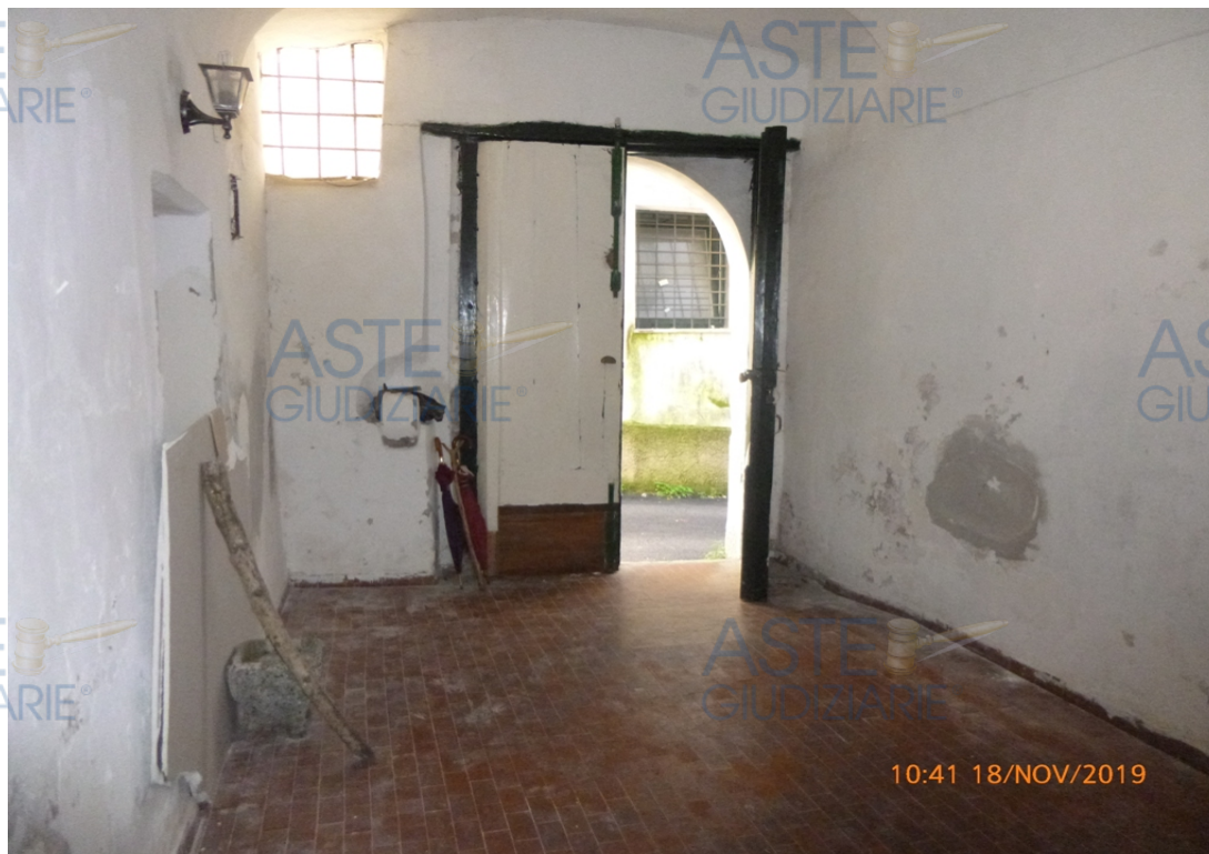
Foto 31 – Androne comune del fabbricato, ripreso in direzione del portone d'ingresso.
