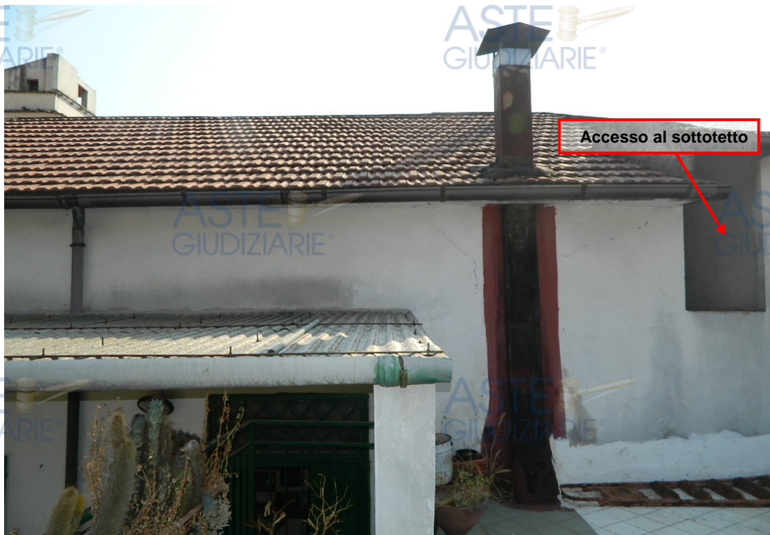
Foto 48: Prospetto della copertura con accesso al sottotetto, possibile solo attraverso una scala portatile.
