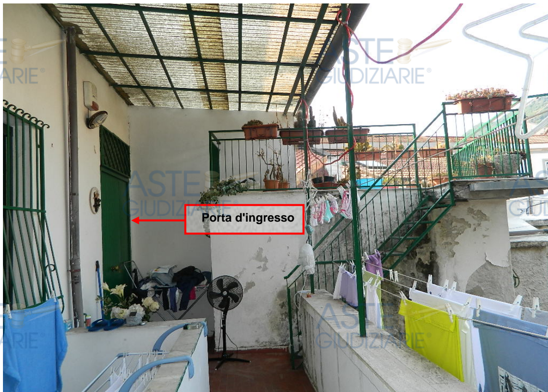
Foto 33: Pianerottolo ove è situato la porta d'ingresso all'appartamento -Bene 3.
