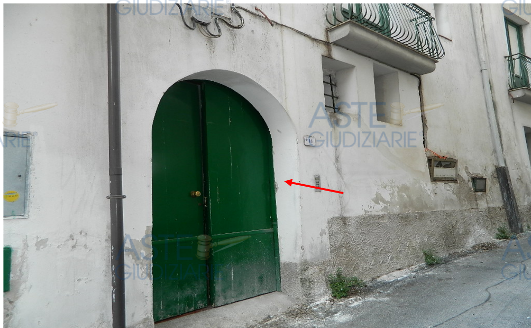
Foto 30: Prospetto del fabbricato, ripreso dalla Via Giudice Mattei, civ. 16, al cui interno è ubicato il Bene 3.
