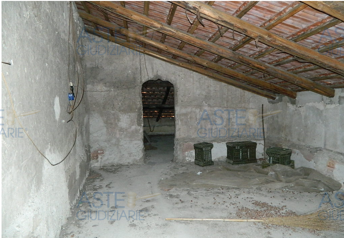
Foto 49: Interni del sottotetto allo stato grezzo.
