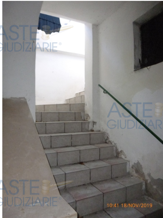
Foto 32: Rampa che dall'androne conduce al piano primo.
