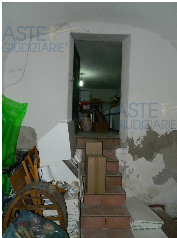
Foto 51: Prospetto dell'accesso dall'androne comune al deposito situato al piano ammezzato dell'edificio.
