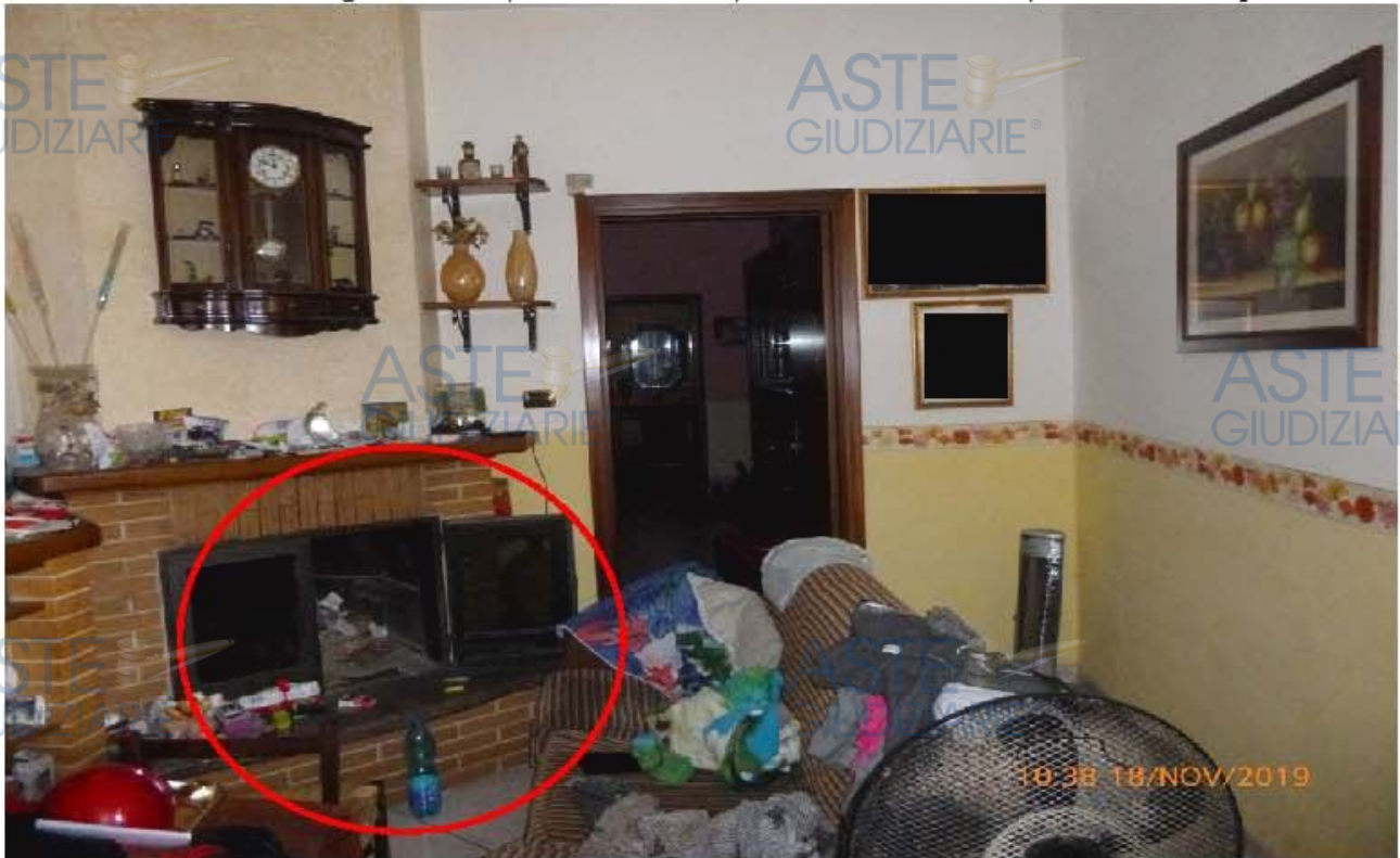
Foto 35: Ingresso-cucina con particolare del camino ad angolo e sovrastante controsoffittatura per l'alloggiamento dei faretti.
