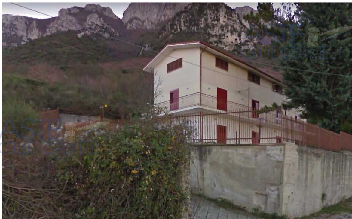
Prospetto principale , visibile dalla strada vicinale di accesso Via Pescone
