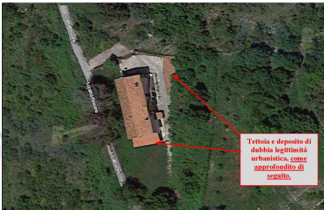
Ortofoto, su scala di dettaglio del fabbricato LOTTO UNICO, ubicato nella zona semicentrale del Comune di Postiglione
