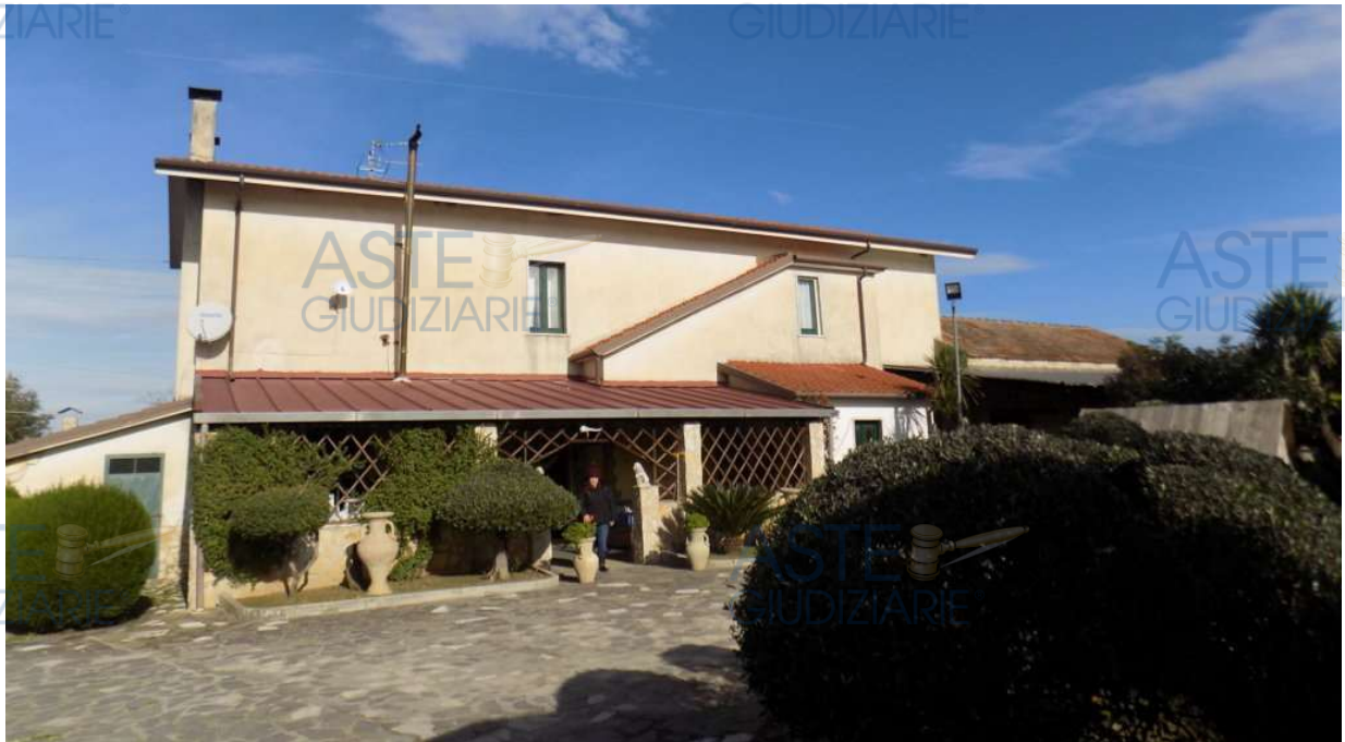
Dettaglio del Prospetto principale dell'Abitazione afferente al Lotto 1
