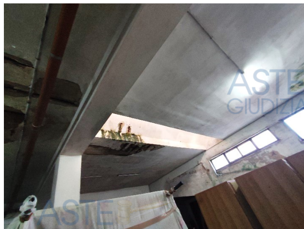
Fig. 21 e 22: Interno deposito pignorato con dettaglio soffitto danneggiato per infiltrazione acqua piovana (dalle oper. perit.)
