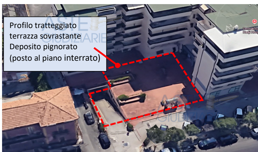
Fig. 3: Foto copertura sovrastante deposito pignorato (da oper. perit.)
