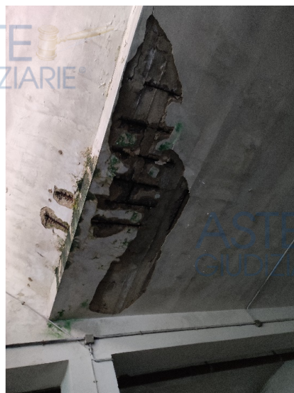
Fig. 19 e 20: Interno deposito pignorato con dettaglio soffitto danneggiato per infiltrazione acqua piovana (dalle oper. perit.)
