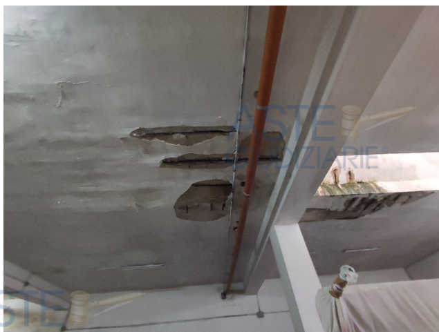
Fig. 21 e 22: Interno deposito pignorato con dettaglio soffitto danneggiato per infiltrazione acqua piovana (dalle oper. perit.)
