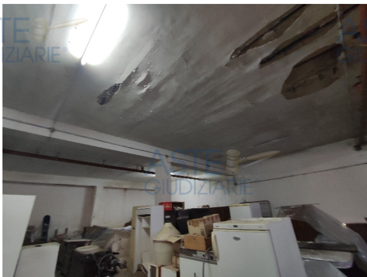
Fig. 19 e 20: Interno deposito pignorato con dettaglio soffitto danneggiato per infiltrazione acqua piovana (dalle oper. perit.)
