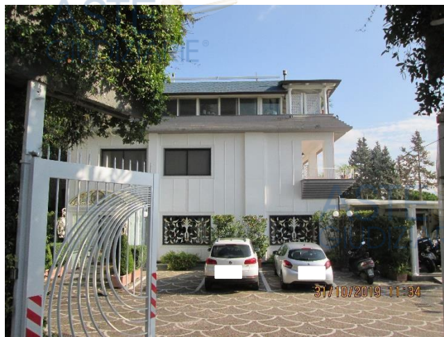
Figura 18: Altra vista dell'area esterna (Ovest) adibita alla sosta temporanea
