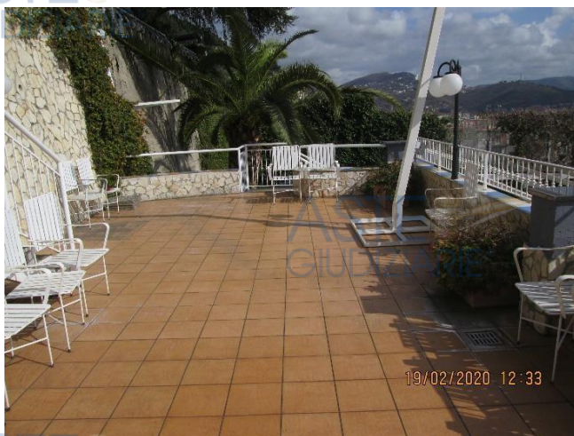
Figura 31: Terrazzo di copertura del sub. 3
