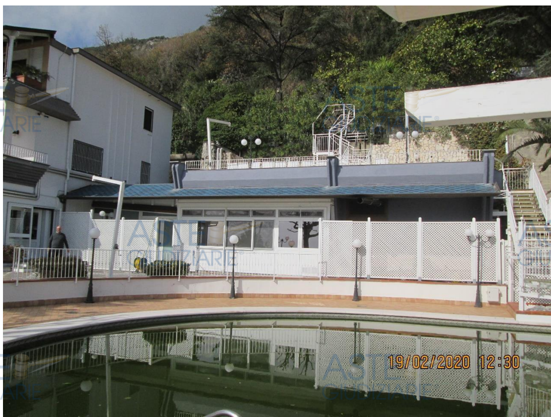
Figura 15: Vista del corpo di fabbrica in aderenza alla struttura principale
