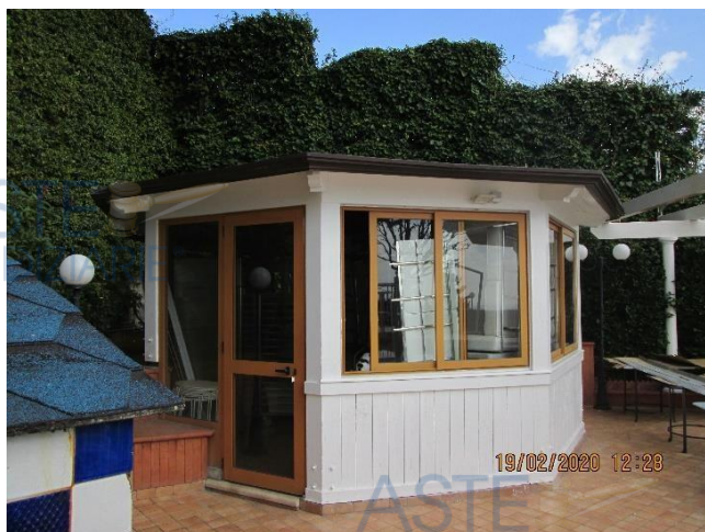
Figura 47: Vista dell'attuale chiosco
