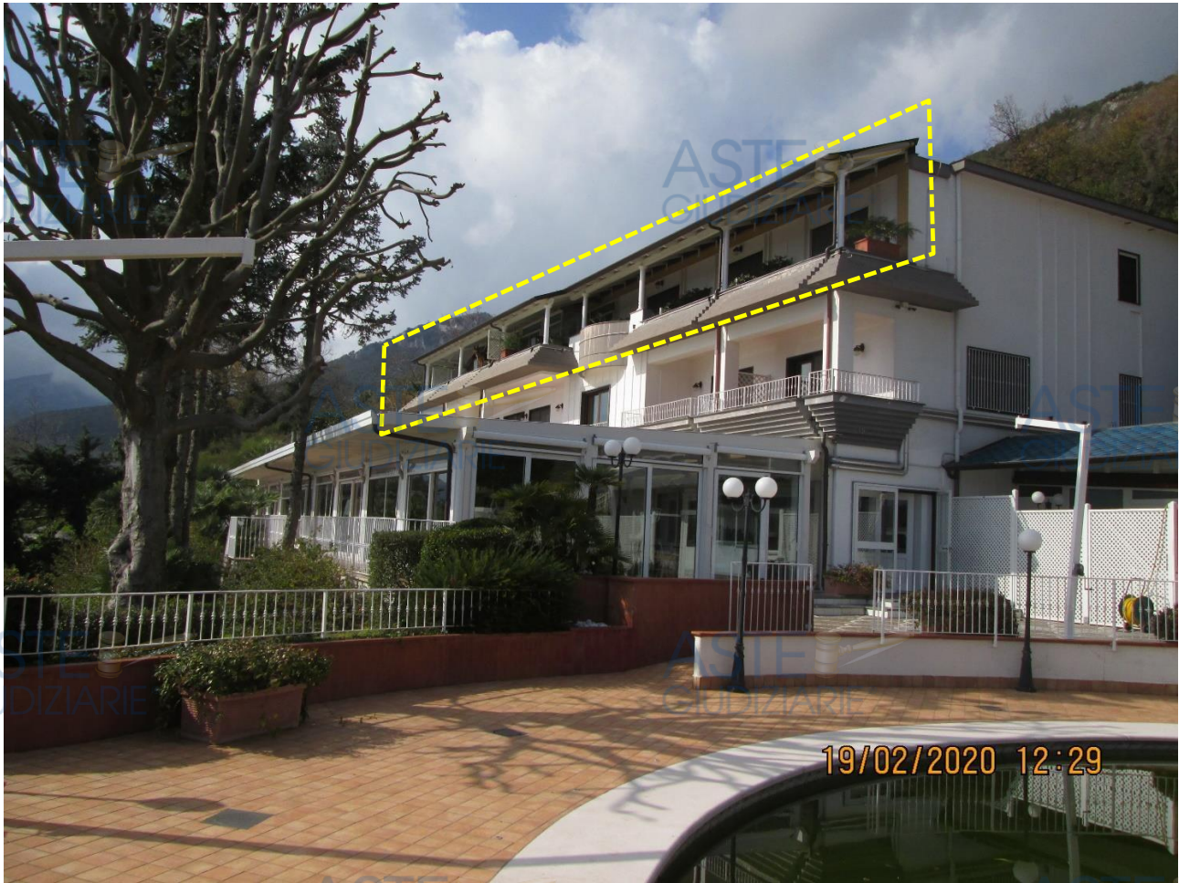
Figura 35: Vista della tettoia non autorizzata al piano secondo
