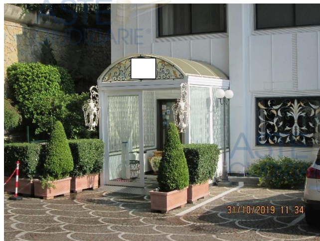
Figura 13: Vista dell'ingresso principale all'albergo
