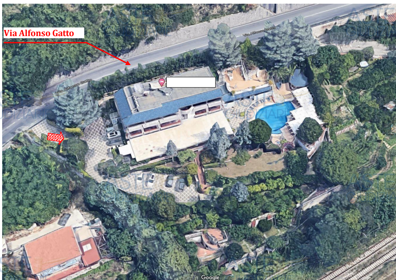
Figura 6 Maggiore dettaglio su ortofoto 3D del complesso staggito (Fonte: Google Maps)
