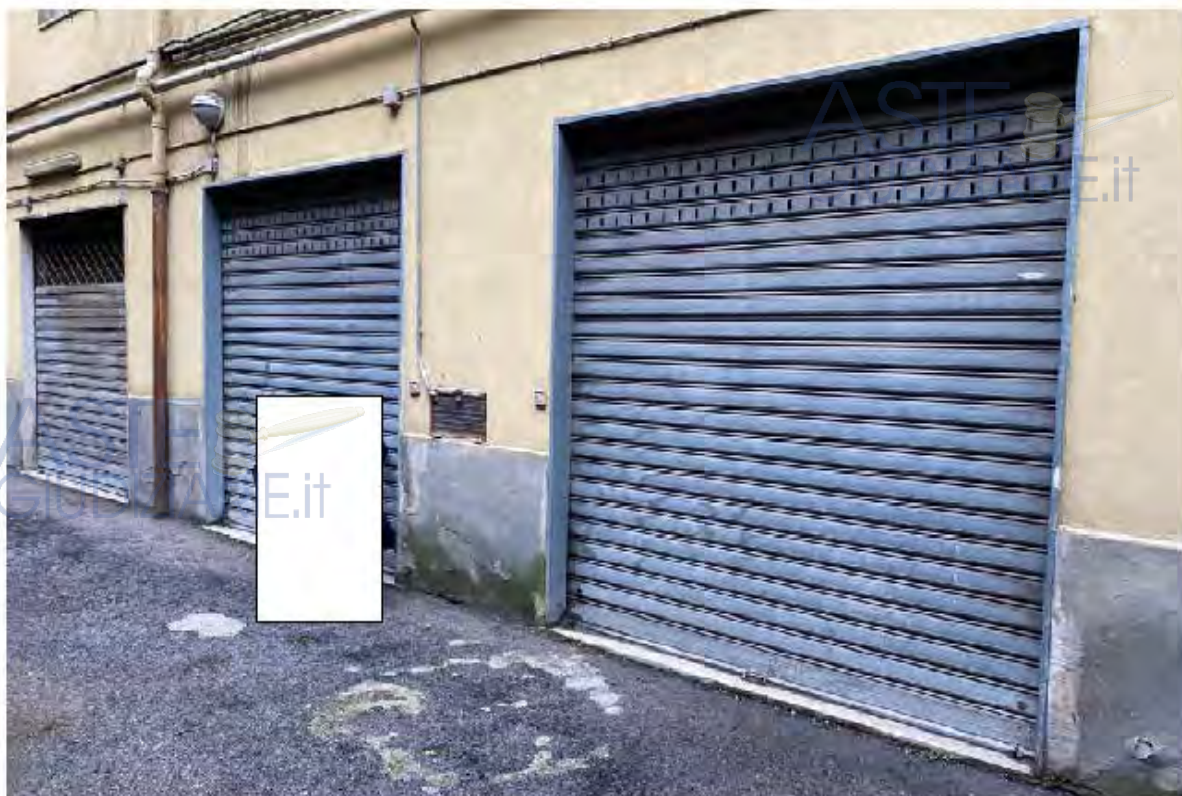
Prospetto principale in cui sono visibili le due saracinesche di accesso al cespite esecutato, sito a piano terra
