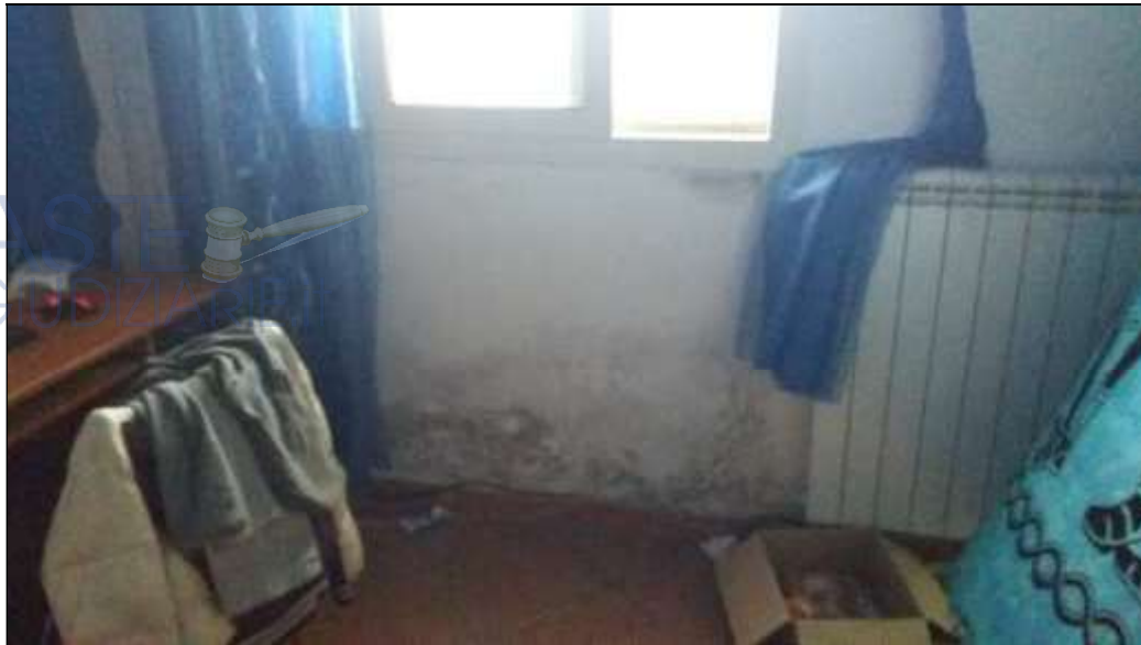
Foto 5- Parete con evidenti segni di infiltrazioni
