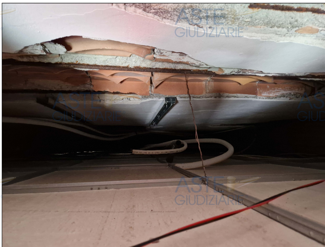
Foto 6: Particolare del solaio e dell'intercapedine tra la copertura e la controsoffittatura
