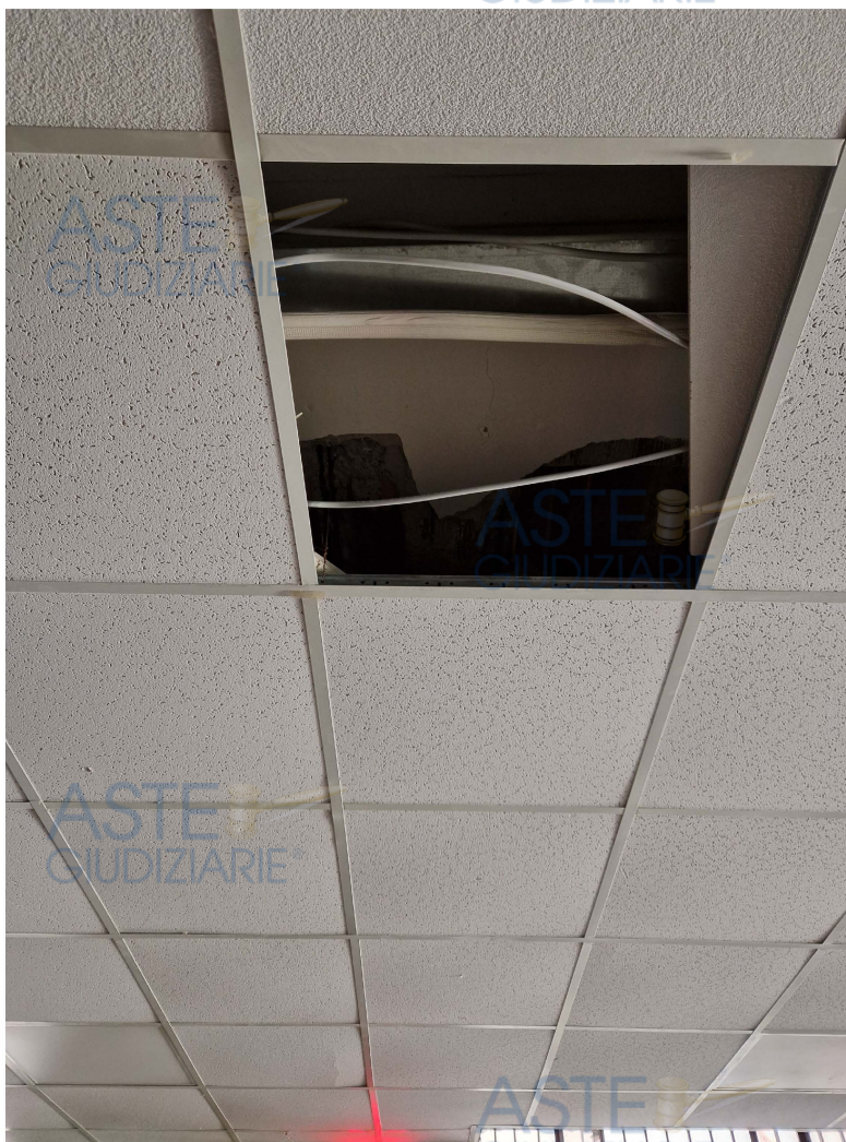
Foto 7: Pannello rimosso per ispezione visiva
