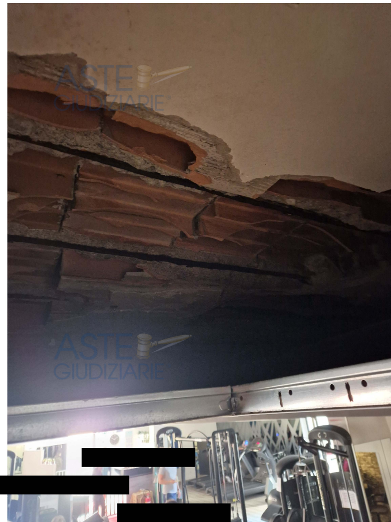
Foto 4: Particolare del solaio e dell'intercapedine tra la copertura e la controsoffittatura
