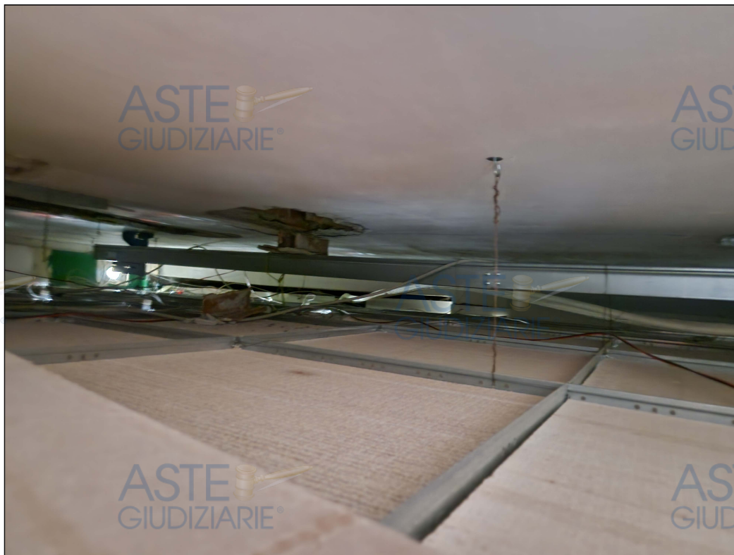
Foto 5: Particolare del solaio e dell'intercapedine tra la copertura e la controsoffittatura
