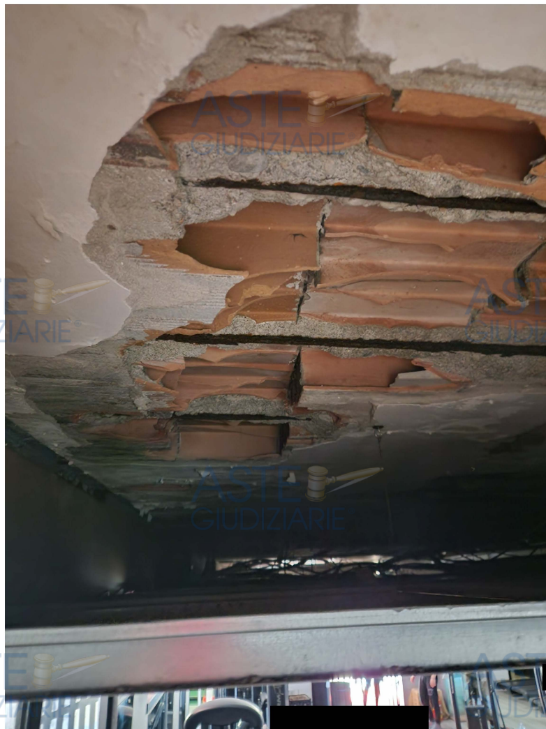
Foto 3: Particolare del solaio e dell'intercapedine tra la copertura e la controsoffittatura
