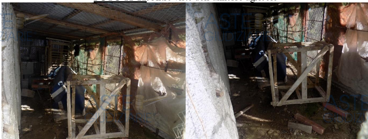
FOTO 13-14: Tettoia/portico retrostante, con tettoia in lamiera e teli perimetrali.
