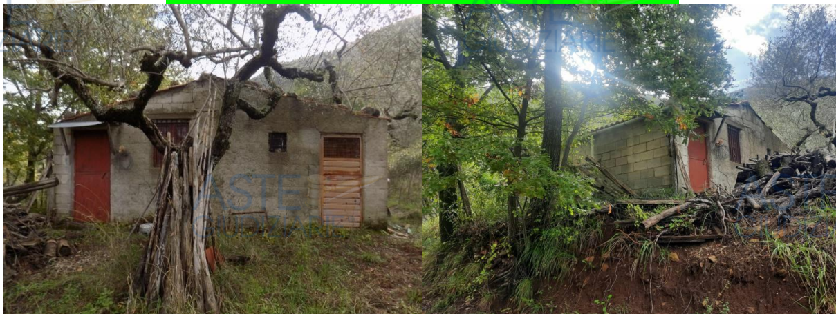
FOTO 9-10: Foto esterni annesso agricolo, strutturato in due vani. Delle due porte, il pollaio presenta serratura difettosa.
