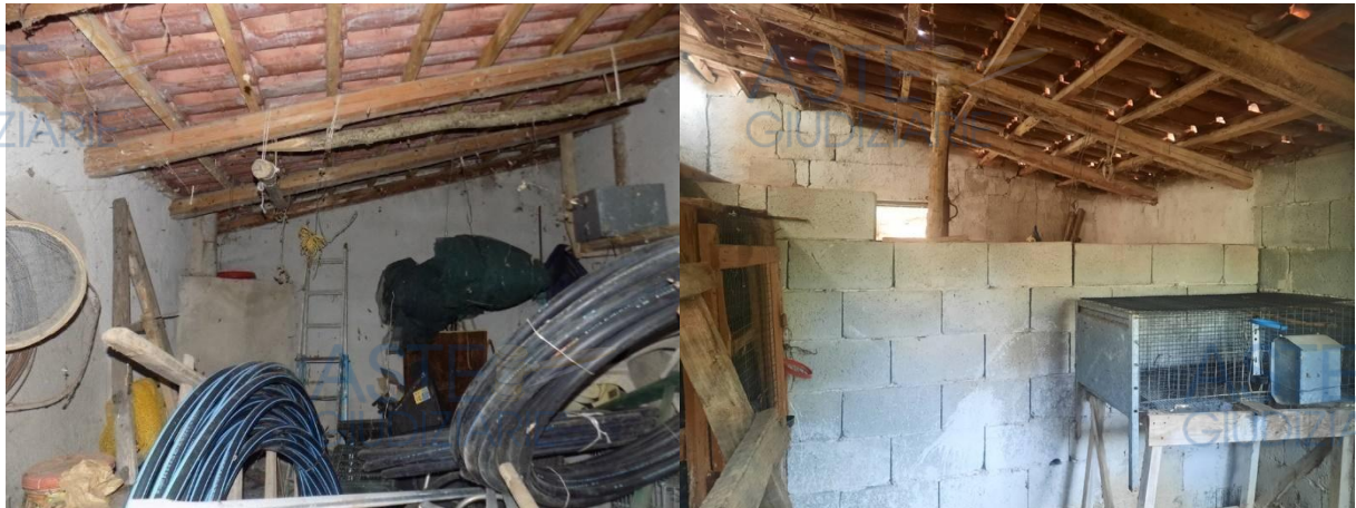
FOTO 16-17: Interni dei due vani dell'annesso agricolo: deposito attrezzature e pollaio, quest'ultimo ripreso dalle feritoie di aerazione, stante la serratura non funzionante .
