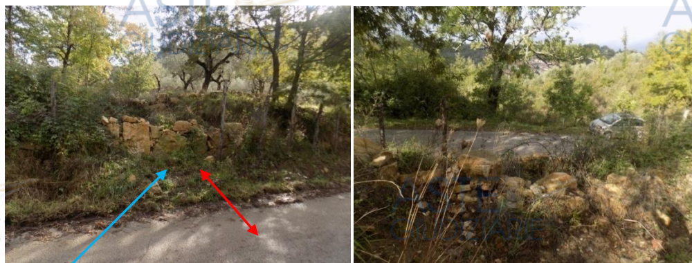
FOTO 3-4: Vista della scarpata, prospiciente la SS18 dalla quale è possibile realizzare un nuovo accesso carrabile alternativo al Lotto 4 direttamente sulla Part.515 Pignorata in estensione .
