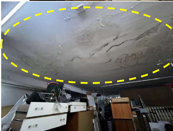
Foto rilievo del 15.03.2023: Panoramica degli intradossi del solaio di copertura che presenta in taluni punti della sua estensione, danni da fenomeni infiltrativi provenienti dal lastrico di copertura superiore Sub. 11 di carattere comune a tutto il fabbricato P.lla 429. In diversi punti, addirittura, si registrano percolazioni d'acqua ; pertanto, non si esclude la necessità per l'Acquirente di dover acquistare in via endo o extra procedurale, e poi provvedere agli oneri di rifacimento dell'impermeabilizzazione del lastrico solare Sub. 11 , in regime di attuale comproprietà per quota \frac{1}{2} ciascuno in capo all'esecutato OMISSIS e ad altro soggetto terzo estraneo alla presente procedura esecutiva.
