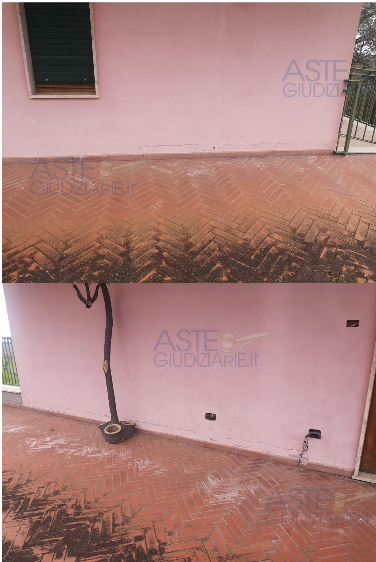
**FOTO 51-52: ULTERIORI PARTICOLARI DI FESSURE CHE AFFLIGGONO ANCHE PORZIONE DI MURATURA ESTERNE ALL'ABITAZIONE**
