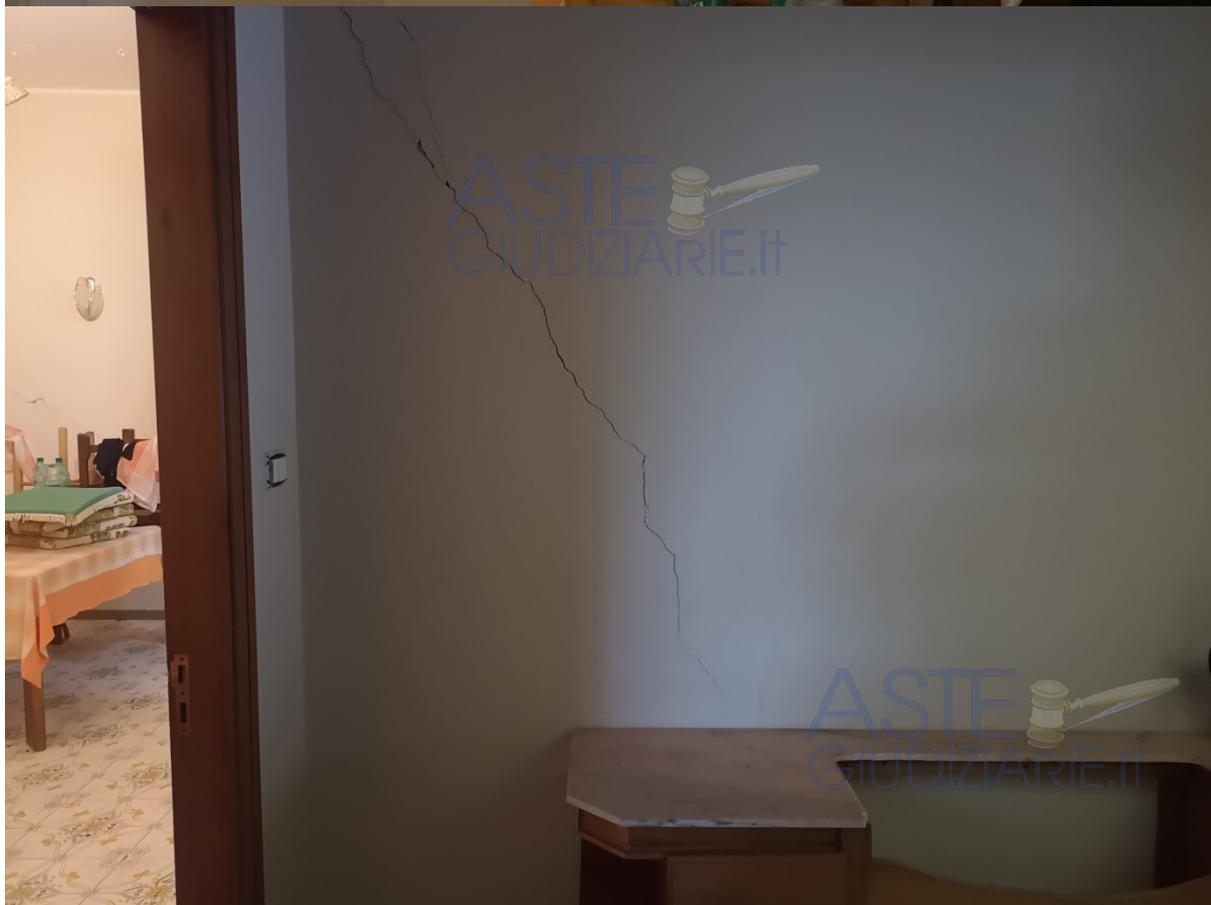
**FOTO 49-50: DETTAGLI DEL QUADRO FESSURATIVO CHE AFFLIGGE TALUNI PORZIONI DI MURATURA AGLI INTERNI DELL'ABITAZIONE**
