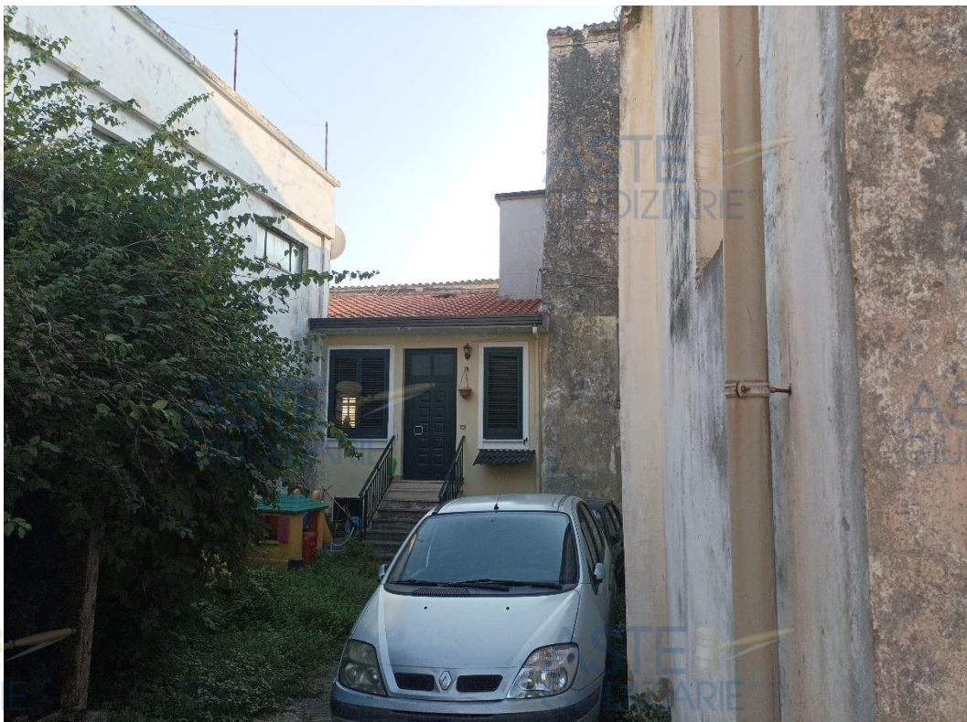
Foto 3 – Vista dell'accesso al fabbricato, facente parte del Lotto unico pignorato, dalla corte esclusiva.
