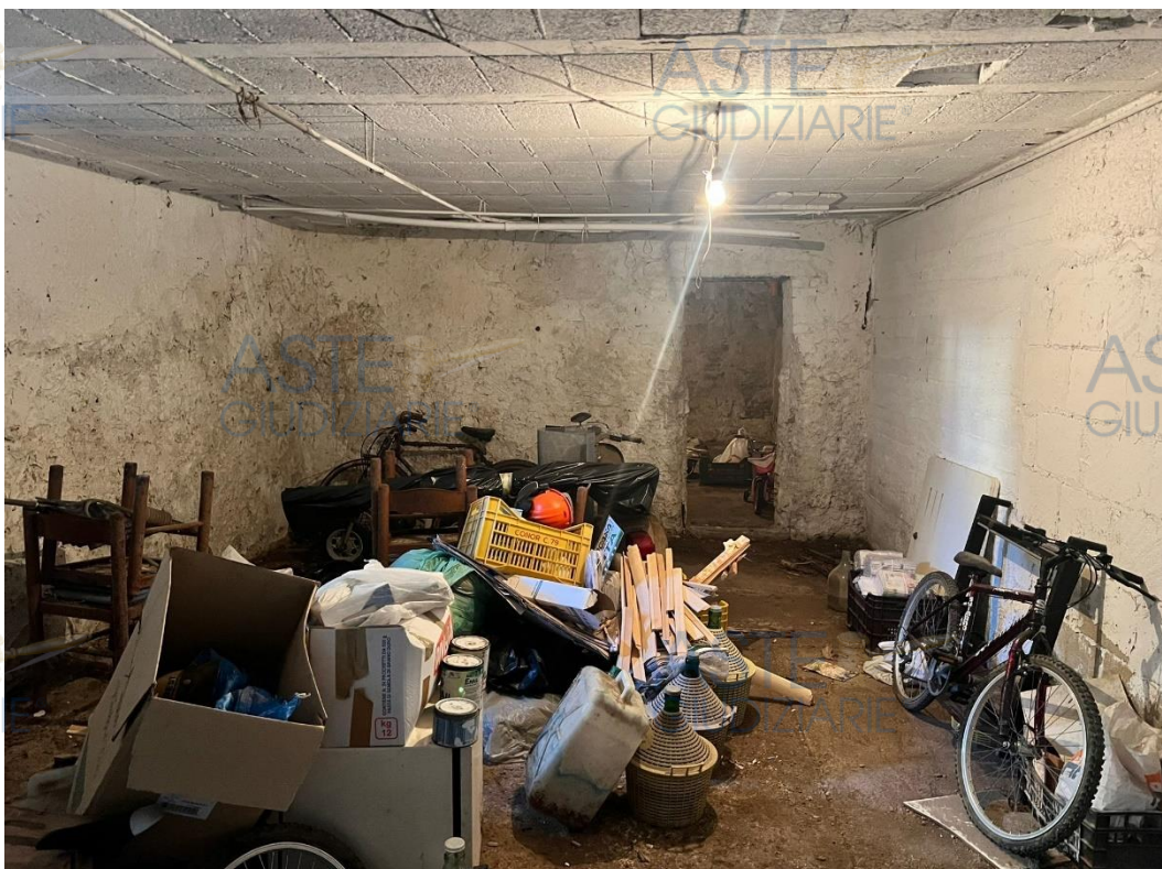
Foto 30 – Piano seminterrato, composto da due vani adibiti a cantina. In evidenza il primo vano, accessibile direttamente dalla corte esclusiva. Si notino le finiture in pessimo stato di conservazione e manutenzione.
