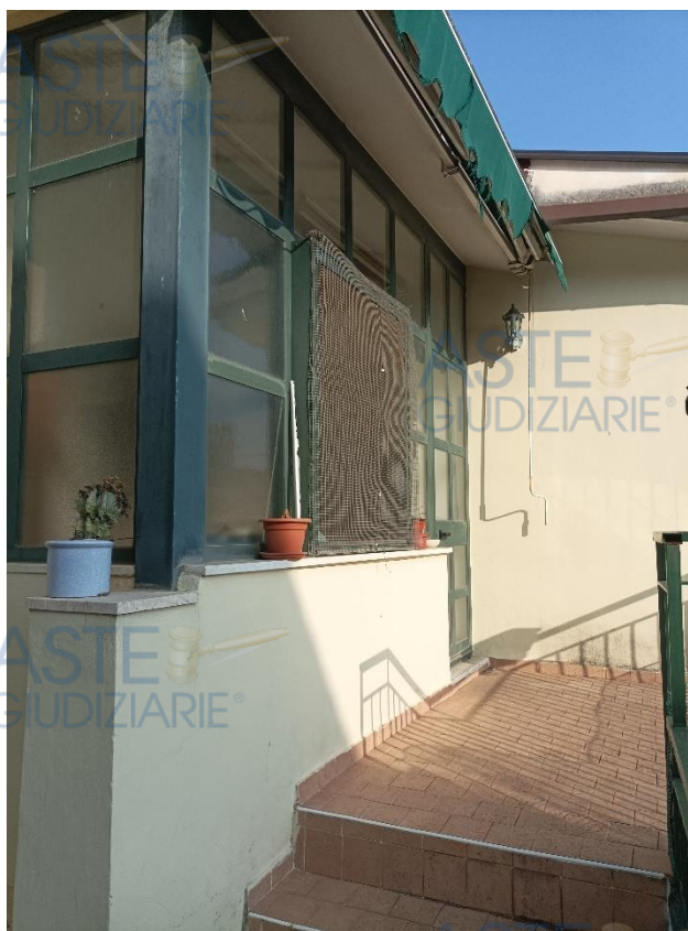
Foto 19 – Il terrazzino a livello e la veranda, visti da altra angolazione. Il terrazzino è posto a diverse quote.
