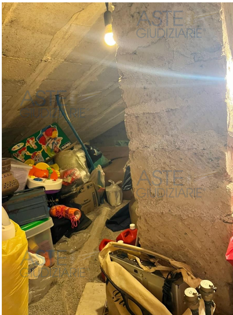
Foto 26 – Parte del sottotetto non abitabile, a causa dell'altezza ridotta.
