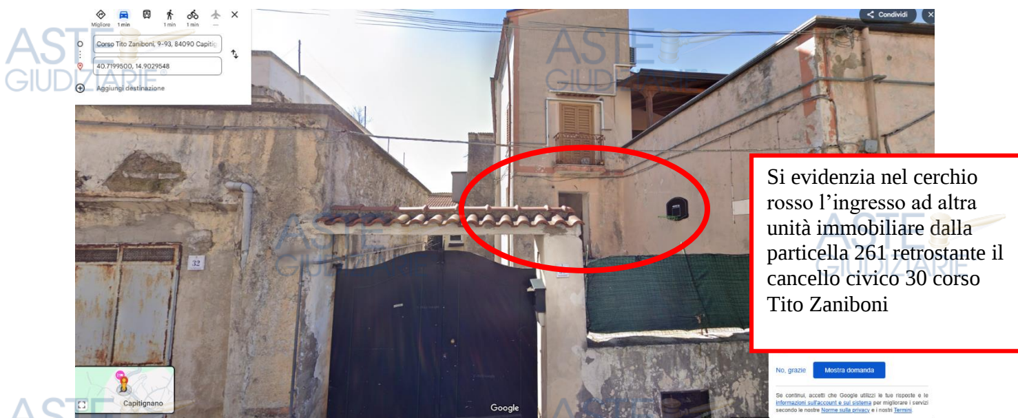
Foto - Vista dell'accesso al fabbricato di ubicazione del Lotto unico pignorato da Corso Tito Zaniboni.
