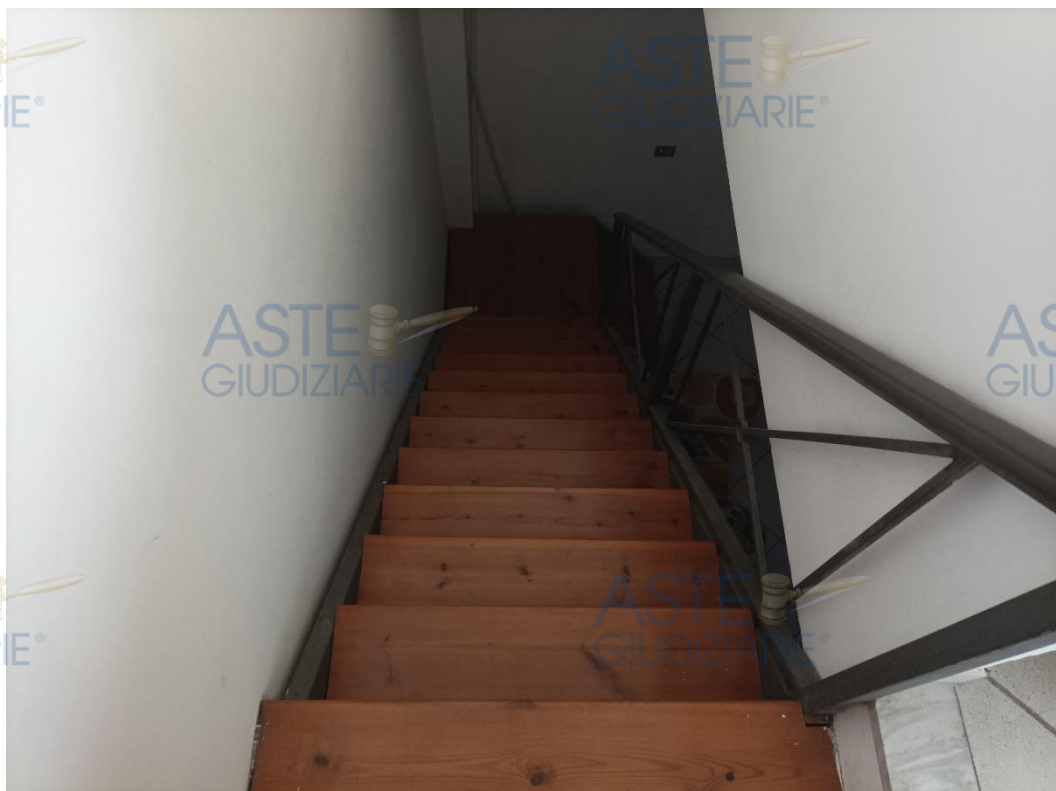
Foto 22 – Scala in ferro e legno che dallo studio ubicato al piano rialzato conduce al piano sottotetto.
