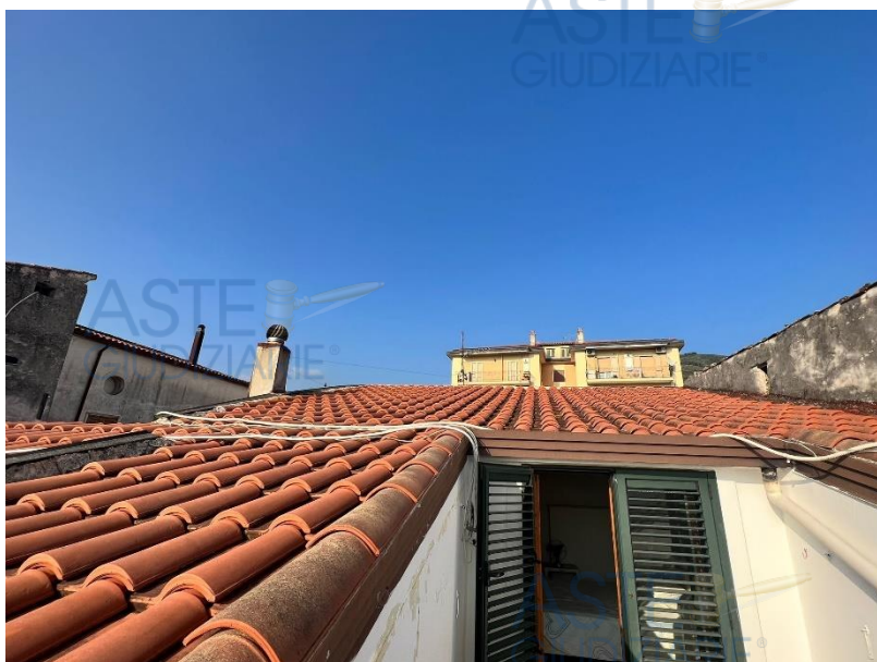
Foto 27 – Terrazzo a tasca al piano sottotetto, accessibile dalla camera da letto.
