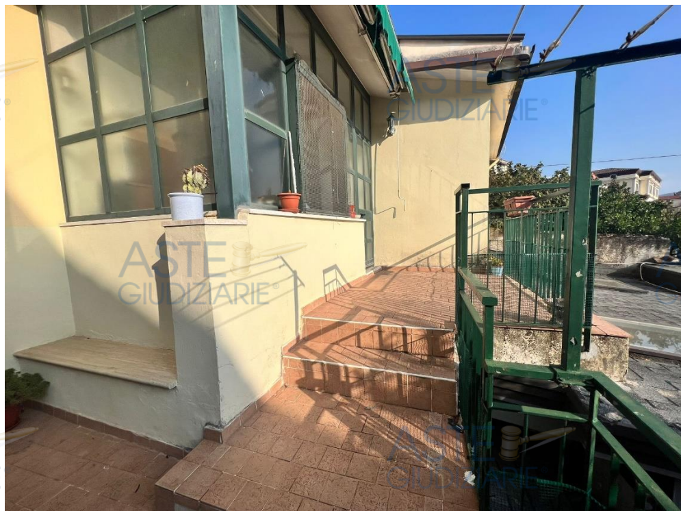
Foto 5 – Vista del fabbricato, facente parte del Lotto unico pignorato, da sud – ovest. In evidenza, il terrazzo a livello e la veranda.
