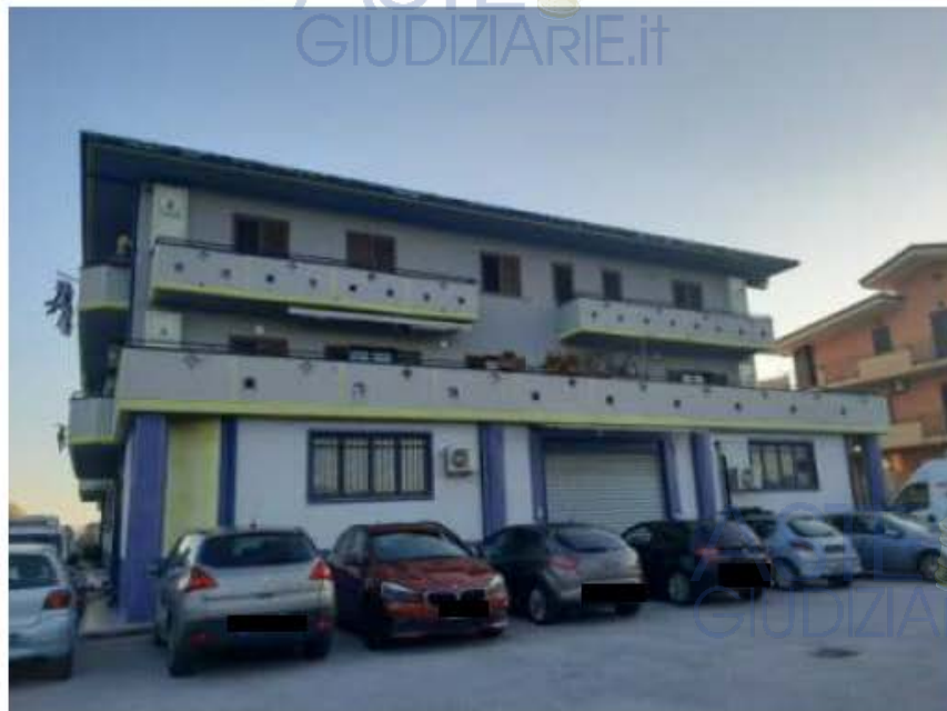
Foto 1 – Vista del Prospetto Nord del fabbricato in cui sono ubicati gli immobili
