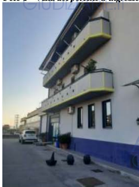
Foto 3 – Vista del lato Est dell'edificio
