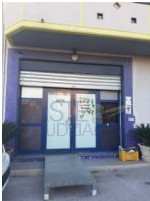
Foto 19–Porta d'ingresso che immette ai locali
