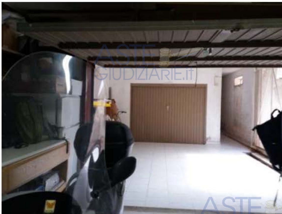
Foto 20 – Vista dall'interno del box verso l'esterno
