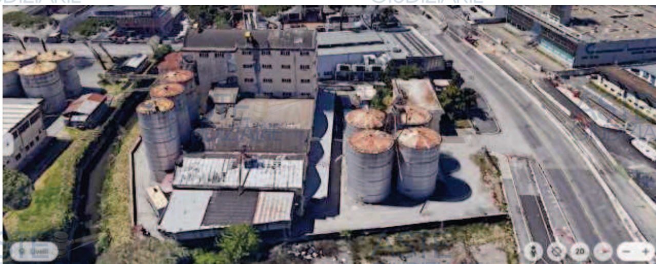
Fig. 8 Fotografia aerea Google Earth vista laterale
