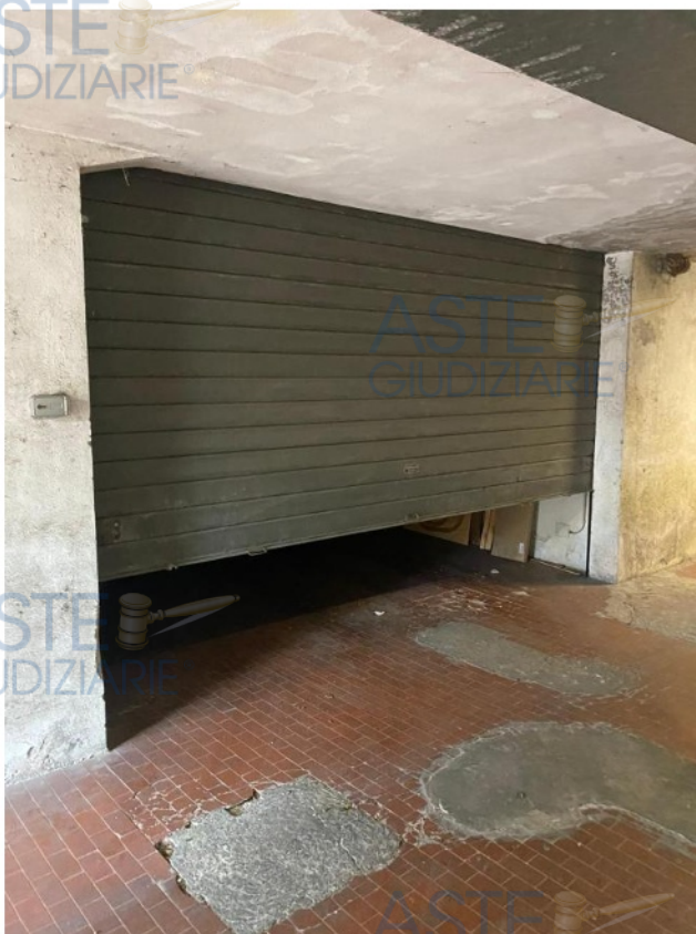
Fig.7 Accesso Box pertinenziale.
