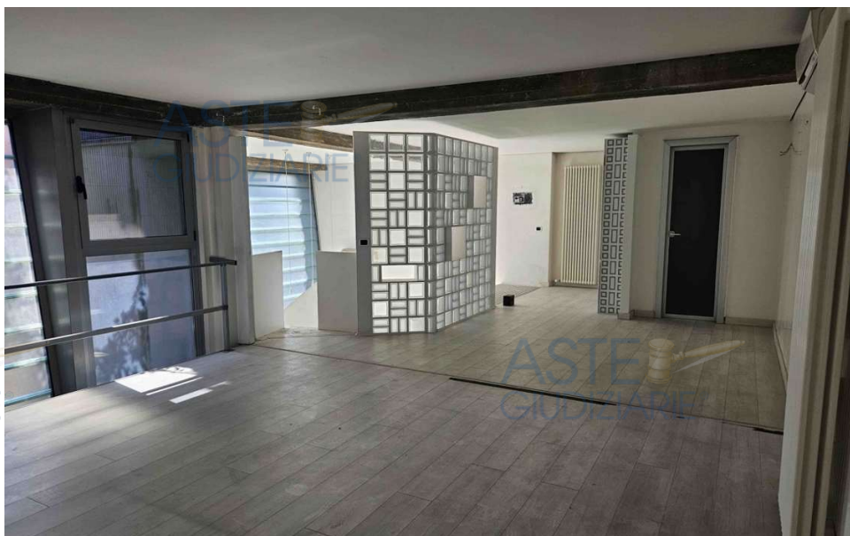
Piano soppalcato - foto 18
