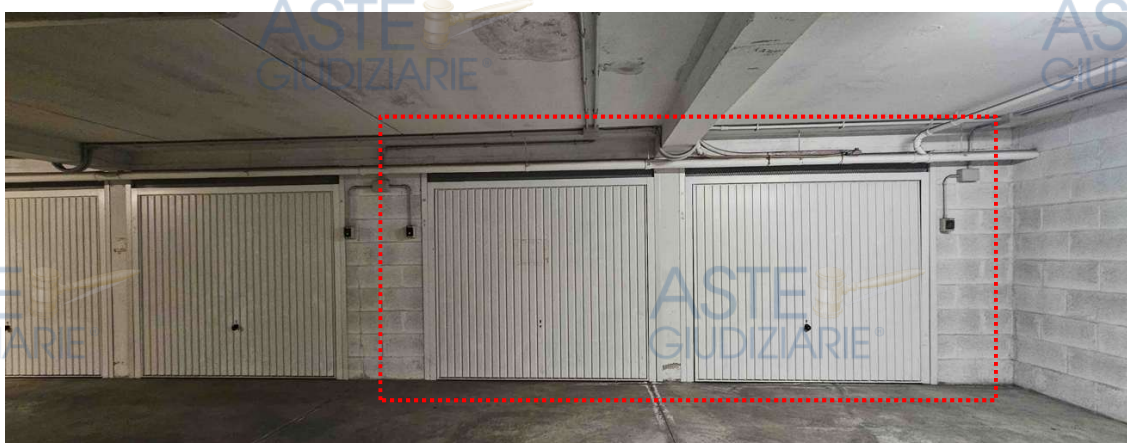
Vista delle due porte di ingresso al box – foto 30
