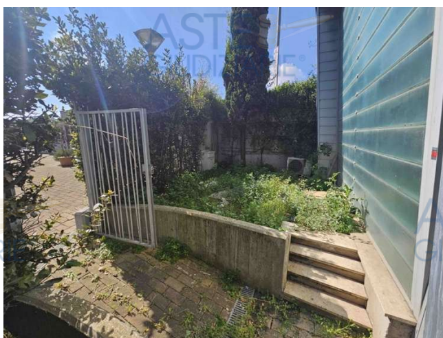
Corte esclusiva del loft – foto 8 e 9
