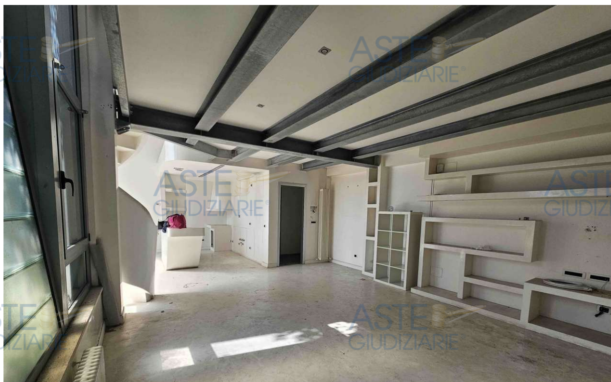
Piano terra - foto 14
