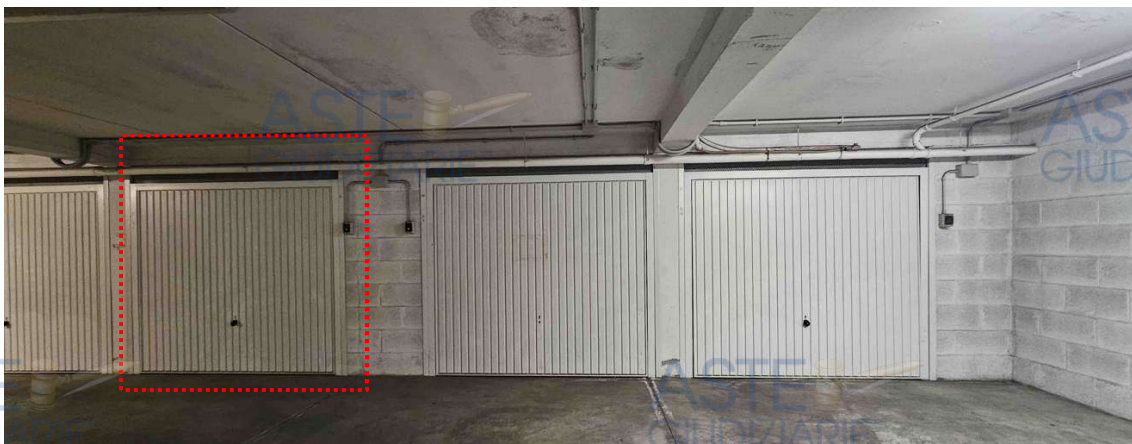
Vista della porta di ingresso al box – foto 33
