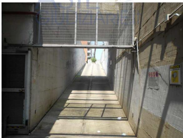
Per il contenimento del terreno e poter realizzare lo scavo è stata realizzata nel perimetro dell'area di pertinenza dell'autorimessa una paratia di pali continua in c.a. del diametro di 80 cm. ,le strutture verticali sono costituite da pilastri in c.a., le strutture orizzontali sono realizzate con travi gettate in opera e solai prefabbricati in c.a.p. dello
