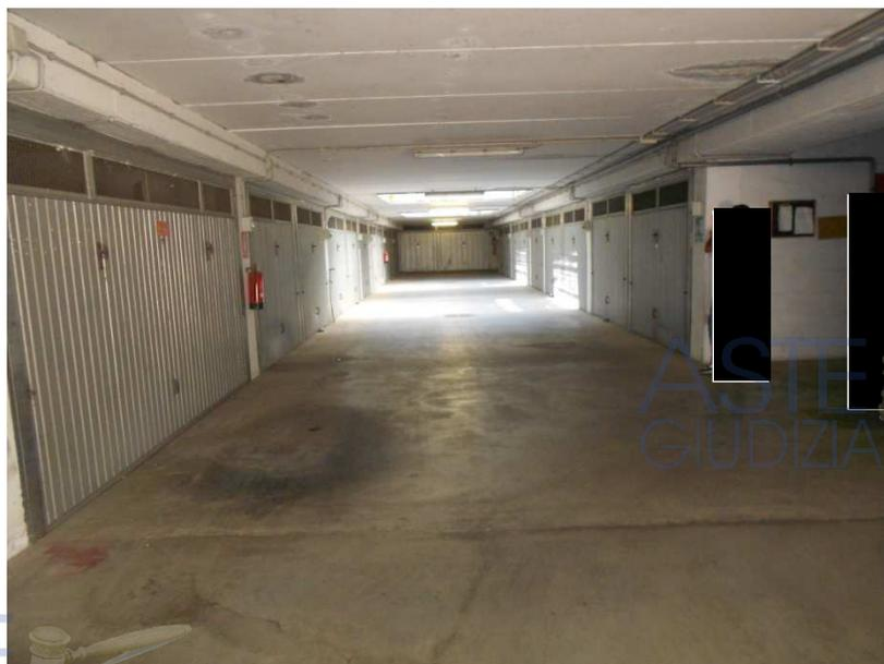
L' autorimessa ha fondazioni su plinti, le strutture verticali sono costituite da pilastri in c.a., le strutture orizzontali sono realizzate con travi gettate in opera e solai alveolari prefabbricati, le pareti portanti e di tamponatura sono in cemento a faccia vista, le tramezzature interne in blocchi di lapillo, pavimenti di tipo industriale e porte basculanti dei box in metallo verniciato a fuoco.
