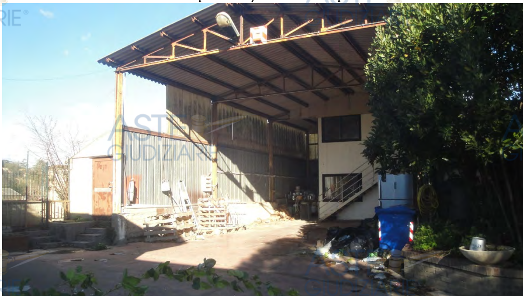
Vista del capannone/autorimessa per veicoli
