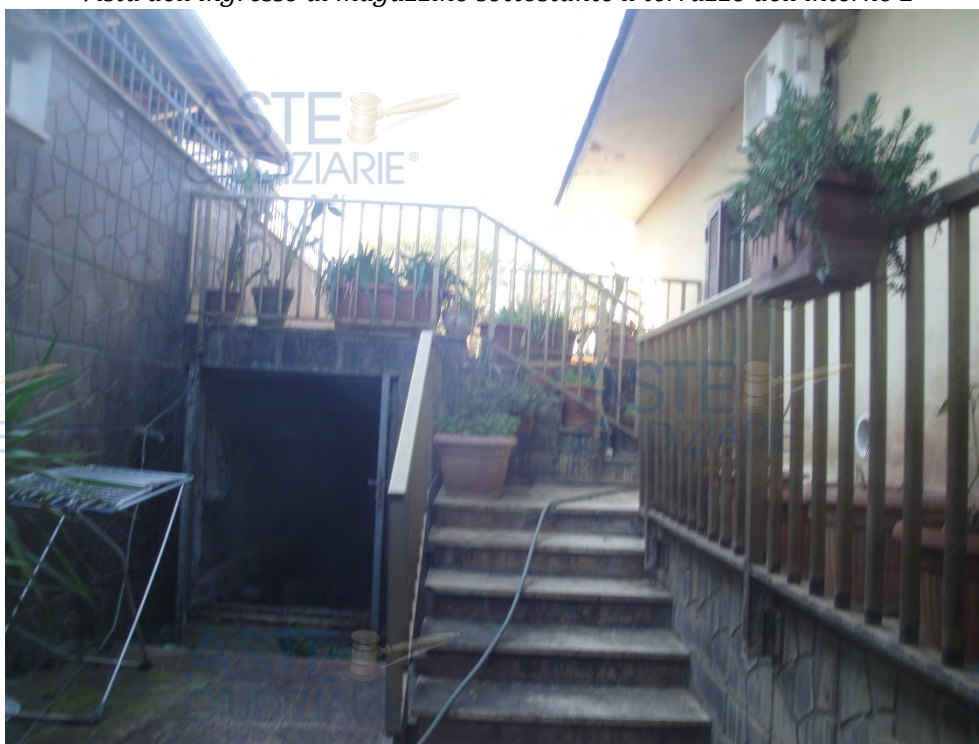
Vista dell'ingresso al magazzino sottostante il terrazzo dell'interno 2
