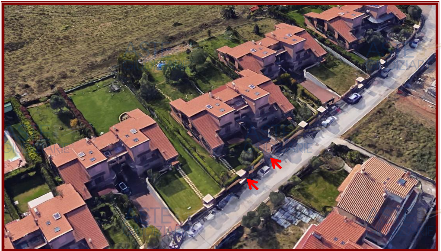
Vista 3D da Google Earth – Vista della porzione di villino bifamiliare con accessi pedonale e carrabile su strada consortile Via Francesco Giacomo Tricomi n. 30 – Int. B4
