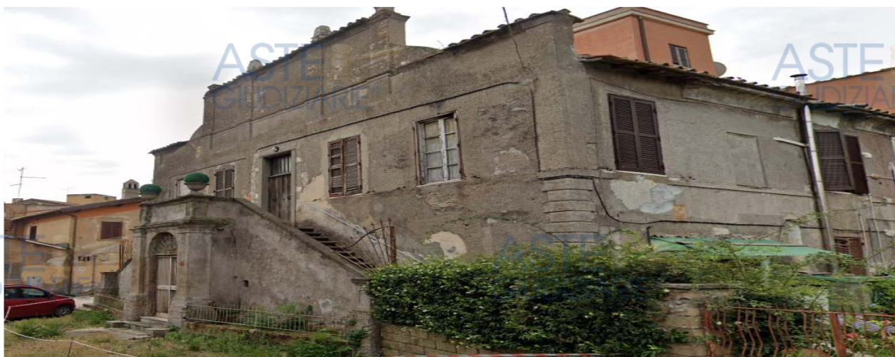
(CASA - STATO ATTUALE DEL PROSPETTO PRINCIPALE)
