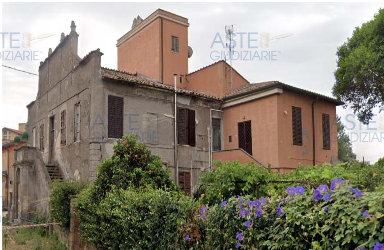
(VISTA LATERALE DEL "CASALE" E DEI RETROSTANTI APPARTAMENTI - DA GOOGLE
