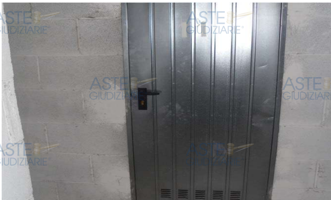
(LOCALE CANTINA AL PIANO S1 – N. 11 - ESTERNO)
