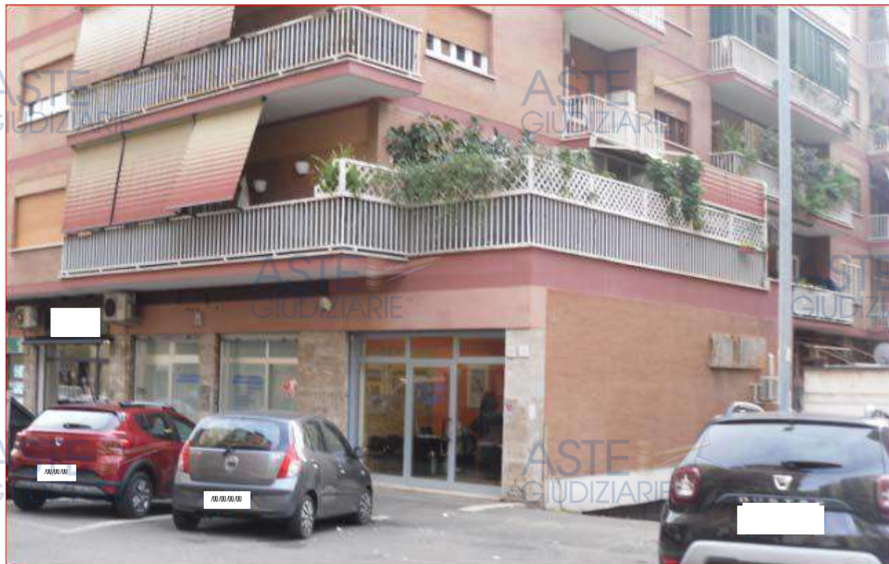
(FOTO ESTERNA – NEGOZIO AL CIVICO 30 DI VIA CASTELFORTE -)
