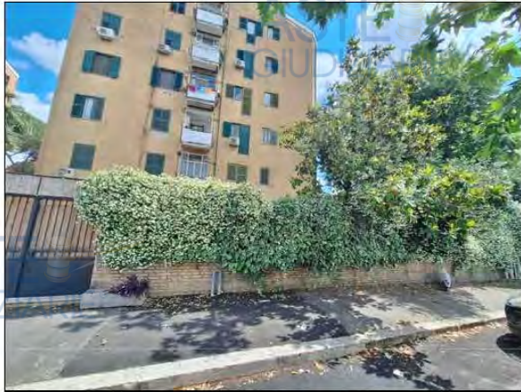
Vista esterna fabbricato su via Tiburtina
