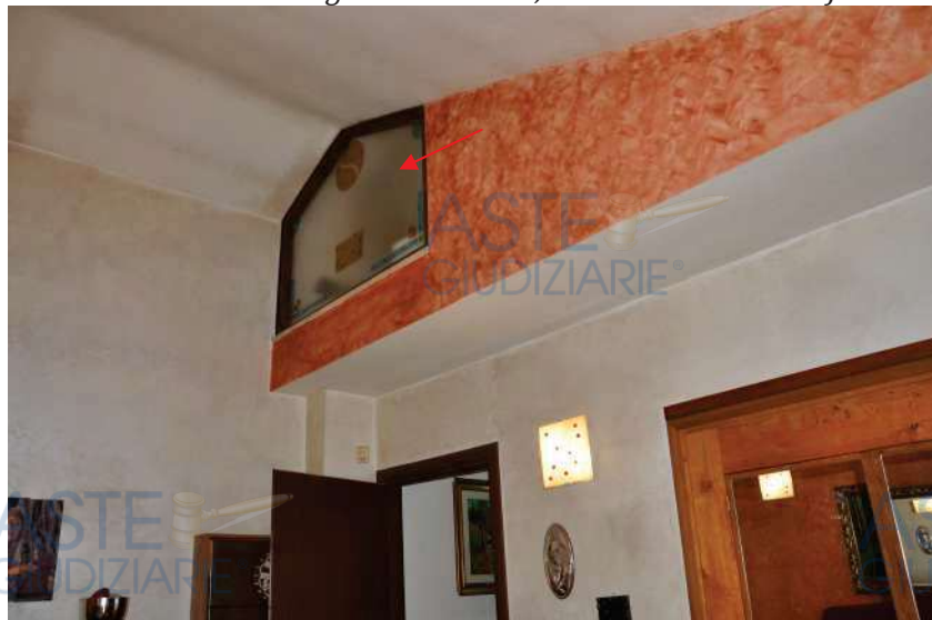
Realizzazione finestra con vetro fisso sul "rimessaggio attrezzi" (oggi camera)
