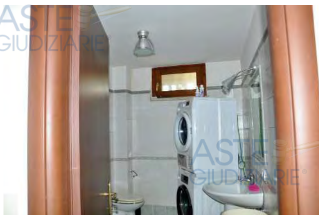
Realizzazione bagno ed uso improprio della cantina
