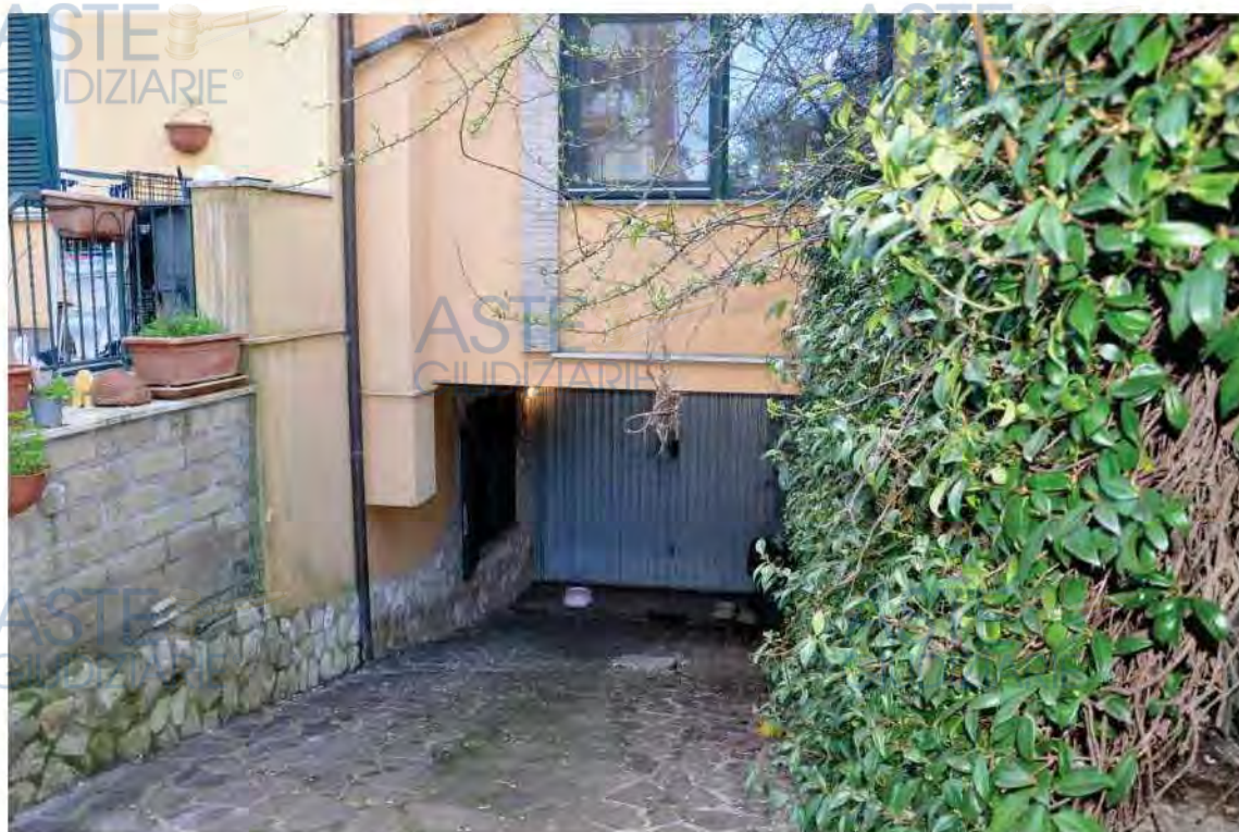
Rampa d'accesso al box auto
