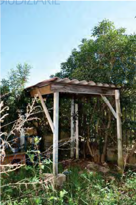
Realizzazione della tettoia
