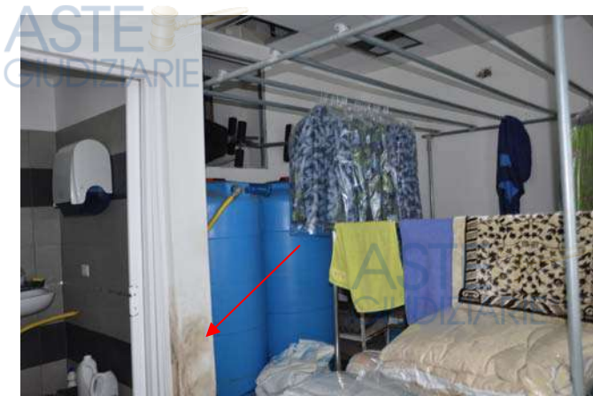
Macchie di umidità al piano S1 e sul controsoffitto
