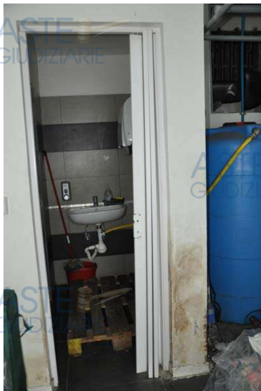
Macchie di umidità al piano S1, impianti in uso dalla lavanderia
