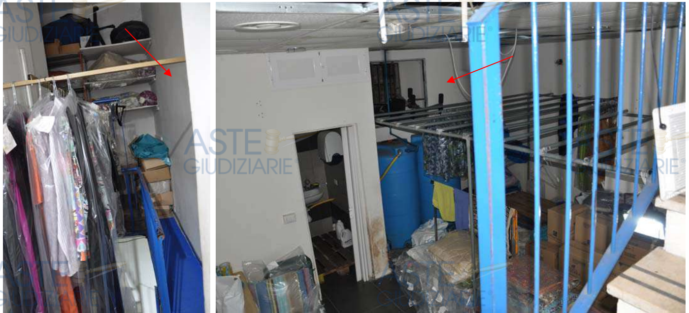
Tamponatura della parete sulla scala e realizzazione contro parete
