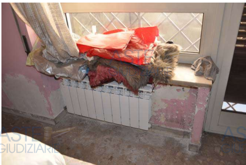
Umidità sui muretti delle finestre
