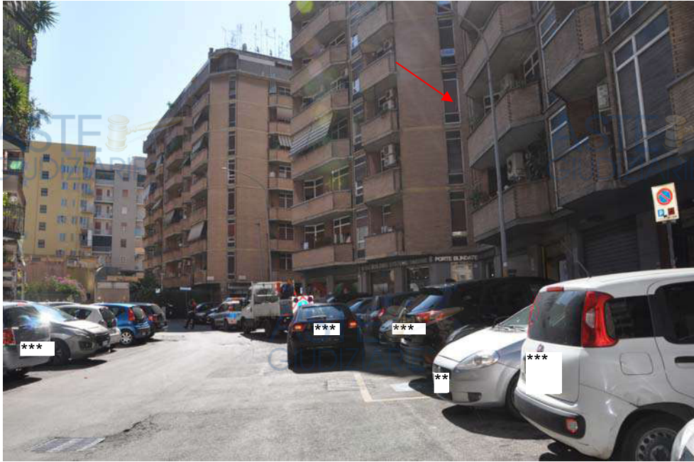
Edificio in esame
