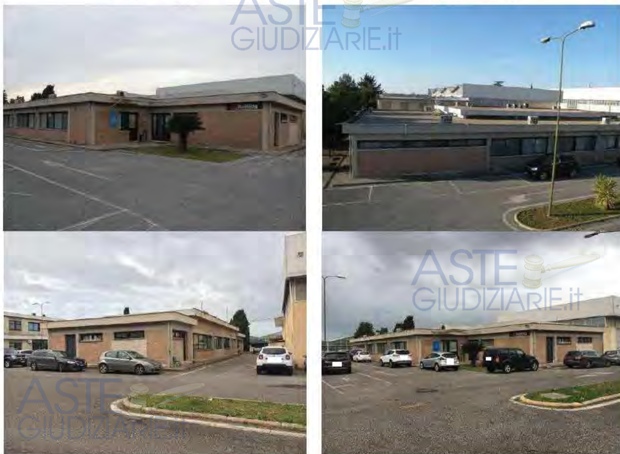
Il fabbricato "C" visto dall'esterno
