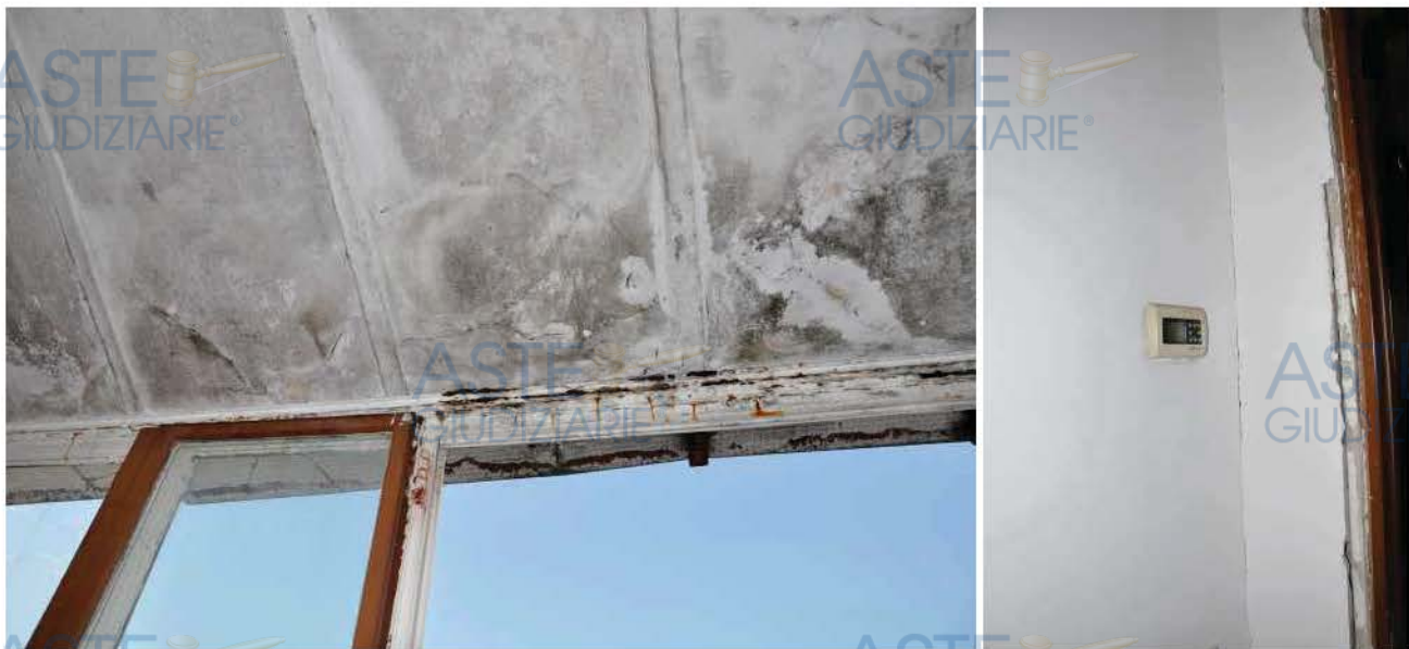
Copertura della veranda e spallette in muratura
