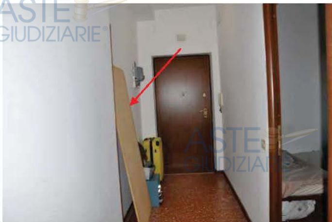
Rimozione spallette in muratura all'ingresso - Rimozione spallette in muratura e trasformazione della cucina in camera da letto
