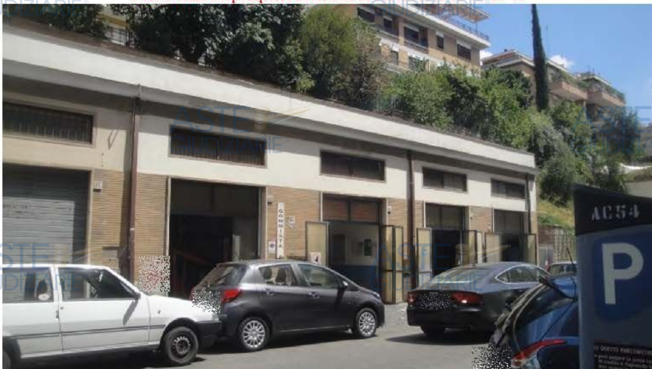
Foto 5 Vista del prospetto del locale di Via Annone 43-45-47-49
