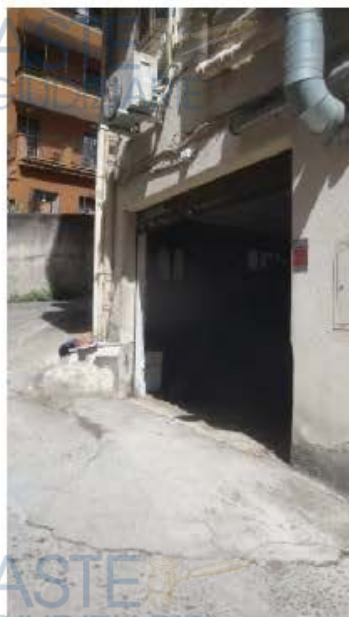
Foto 1 Accesso del locale dalla rampa
