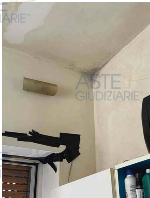
foto 15 – condensa a soffitto cucina e cavi elettrici a vista foto 16 – contatore e quadro elettrico con cavo a vista
