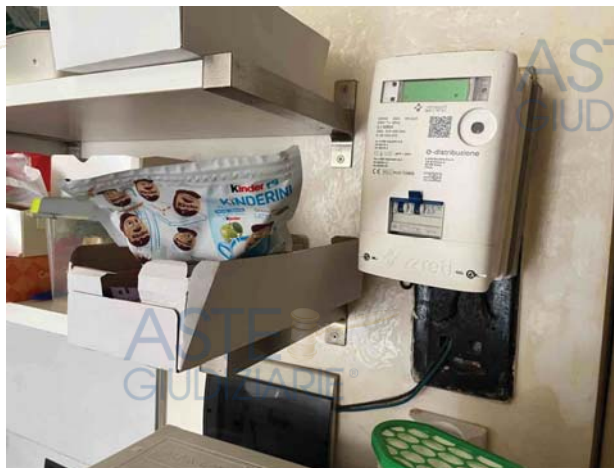
foto 15 – condensa a soffitto cucina e cavi elettrici a vista foto 16 – contatore e quadro elettrico con cavo a vista
