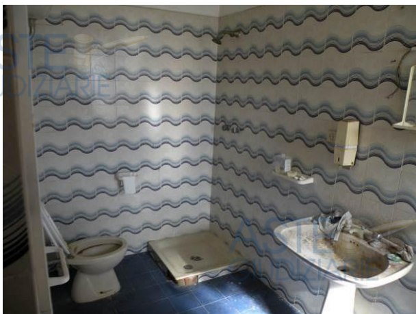
Alcuni ambienti al piano terreno
