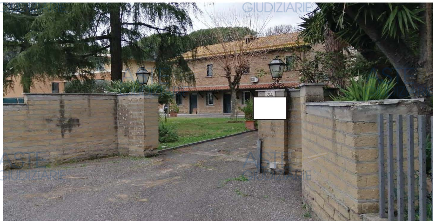
Fig. C – Accesso al fabbricato da via di Poggio verde n. 34
