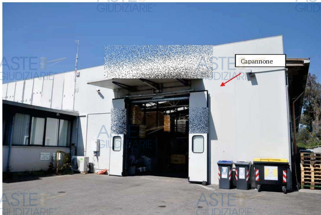
Ingresso al capannone dalla corte
