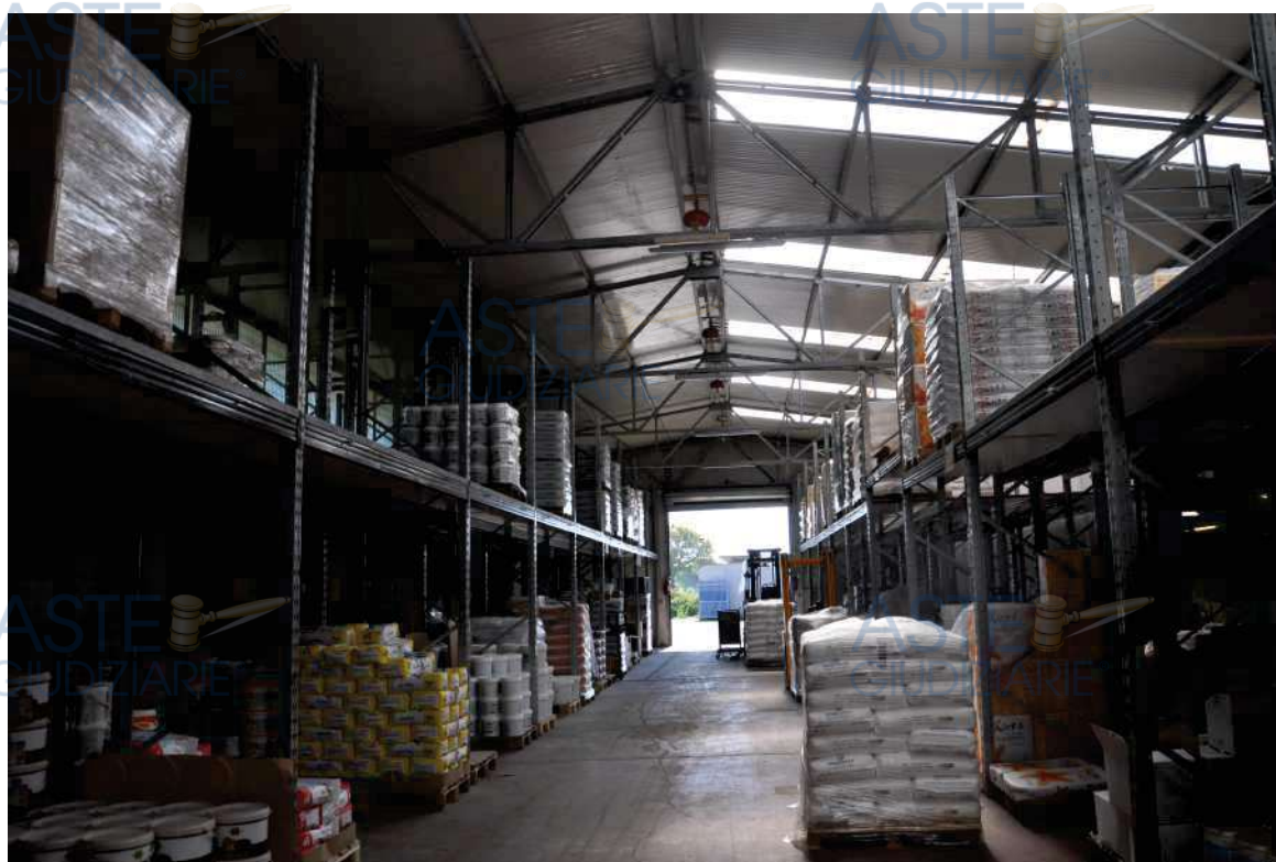
Interno del capannone con strutture metalliche
