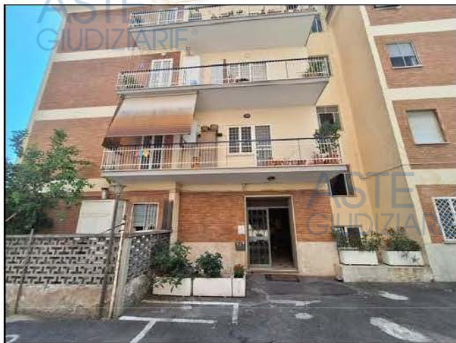
Portone di ingresso alla Palazzina B
