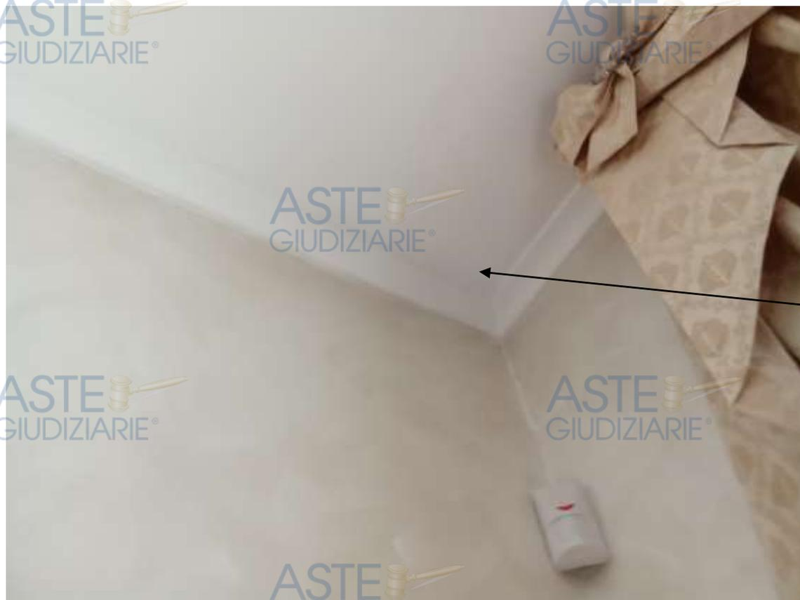
Nel locale lavanderia invece sono presenti fenomeni di fessurazione dell'intonaco che appariva lesionato in più punti a causa della presenza di umidità.
