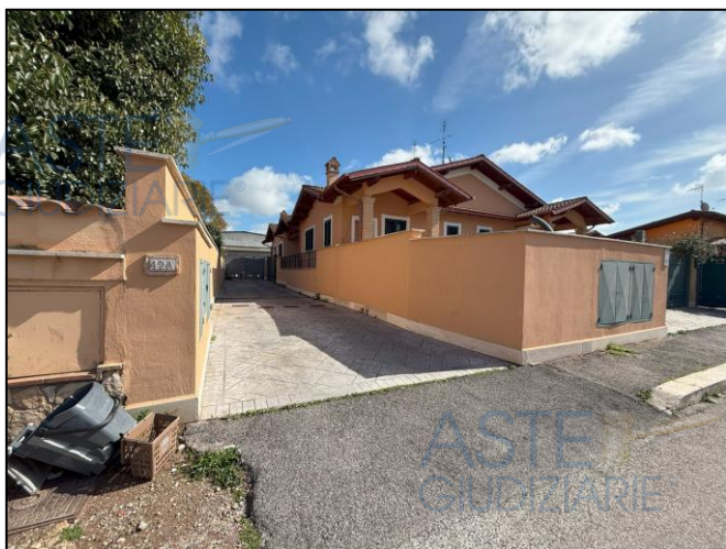
Accesso comune su Via Caiolo
