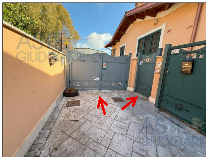
Accesso carrabile e pedonale al civ. 42/a
