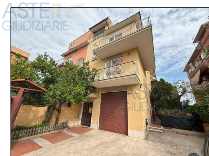
Accesso al box dalla corte comune
