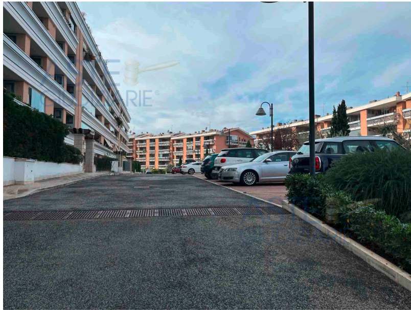
Foto 1 – corsello superiore di viabilità interna – posti auto edificio R12C
