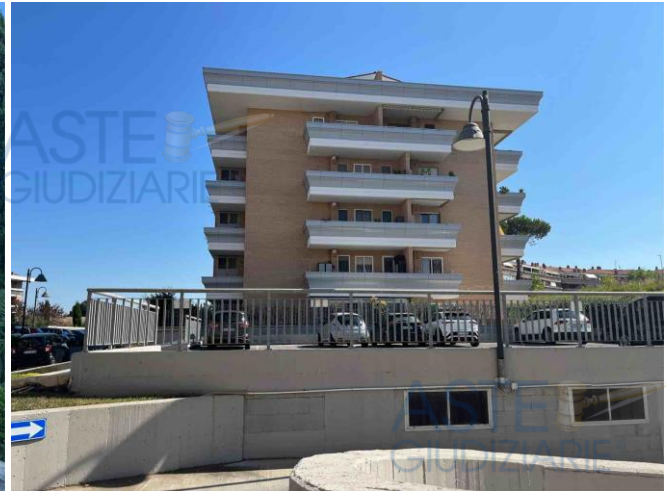
Foto 2 – testata edificio R12C con parcheggio scoperto
