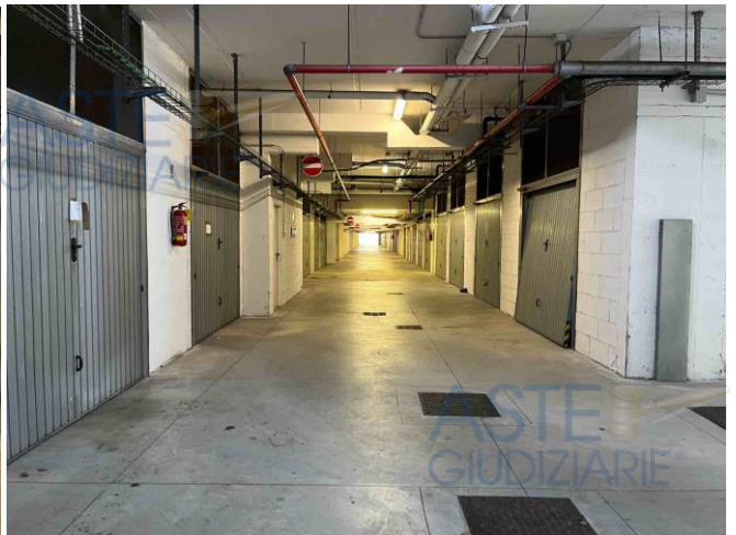
Foto 4 – corsello autorimessa pS2 edificio R12C
