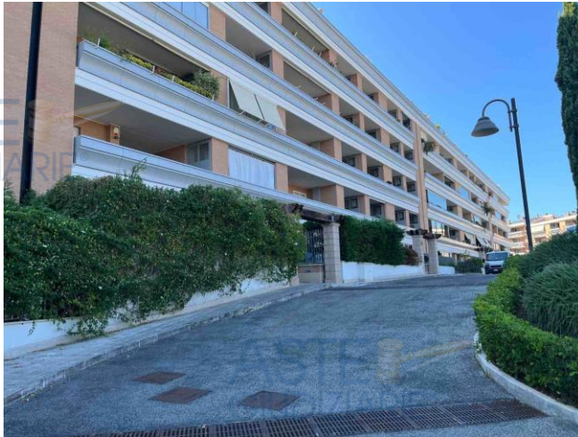
Foto 1 – prospetto longitudinale edificio R12C
