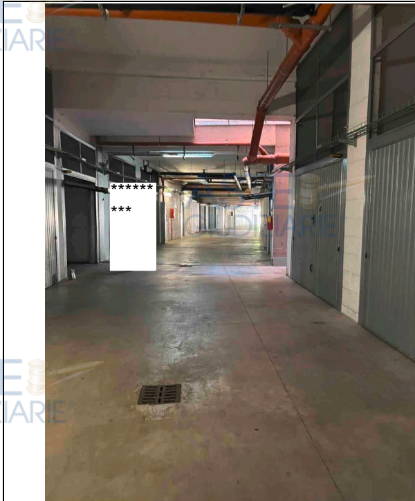
Foto 3 – corsello autorimessa pS1 edificio R12A
