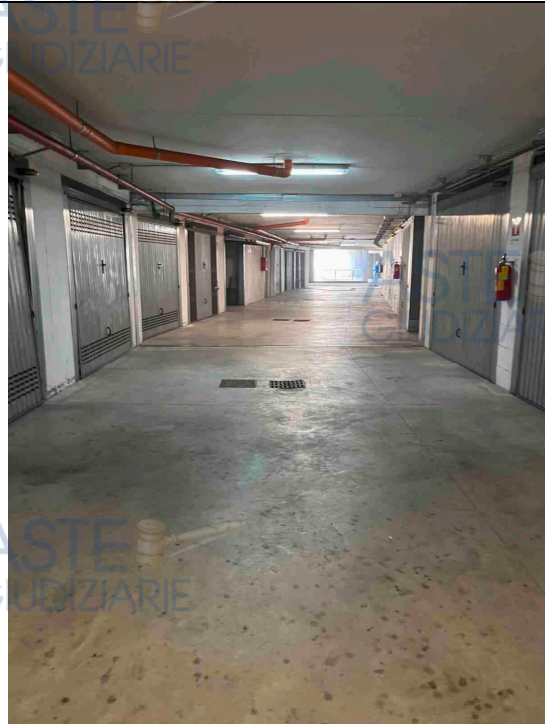
Foto 4 – corsello autorimessa pS2 edificio R12A
