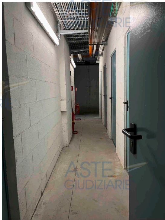
Foto 5 - corridoio cantine da n.10 a n.14 p.S1
