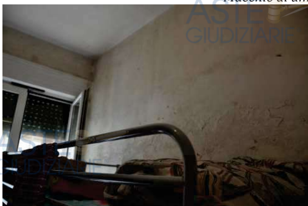
Macchie di umidità e muffa nella camera e nel bagno
