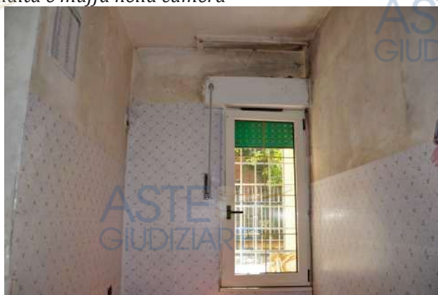
Macchie di umidità e muffa nella camera e nel bagno
