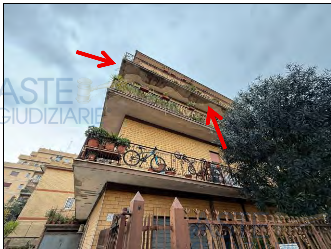
Vista dei sottobalconi
