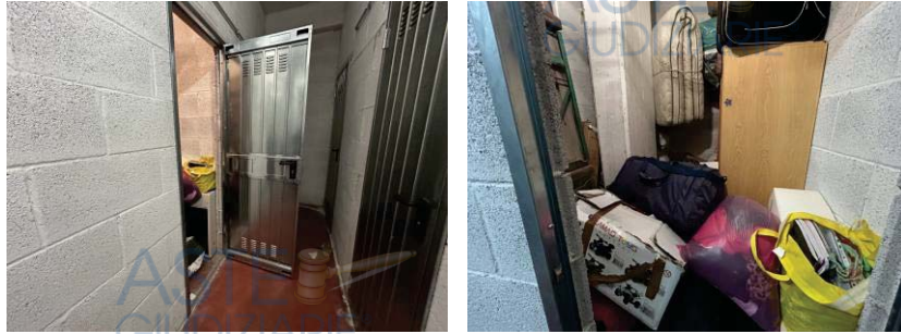
SUB.38: la cantina, risulta in buono stato conservativo
