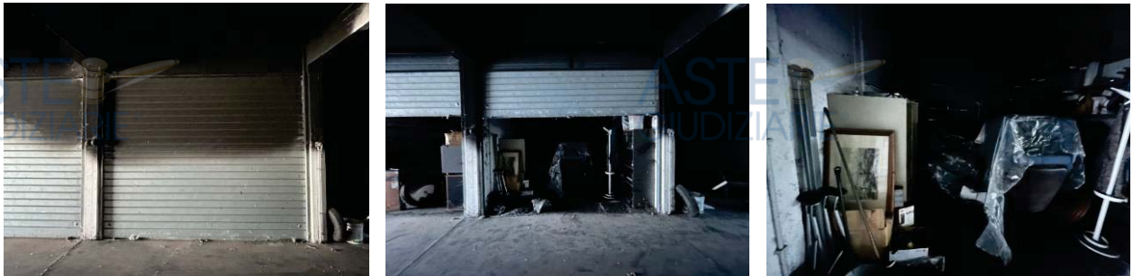
SUB.24: il box auto, risulta in buono stato conservativo
