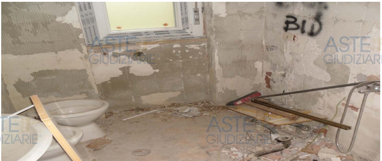
(ZONA BAGNO - INTERVENTI DI RISTRUTTURAZIONE NON ULTIMATI)
