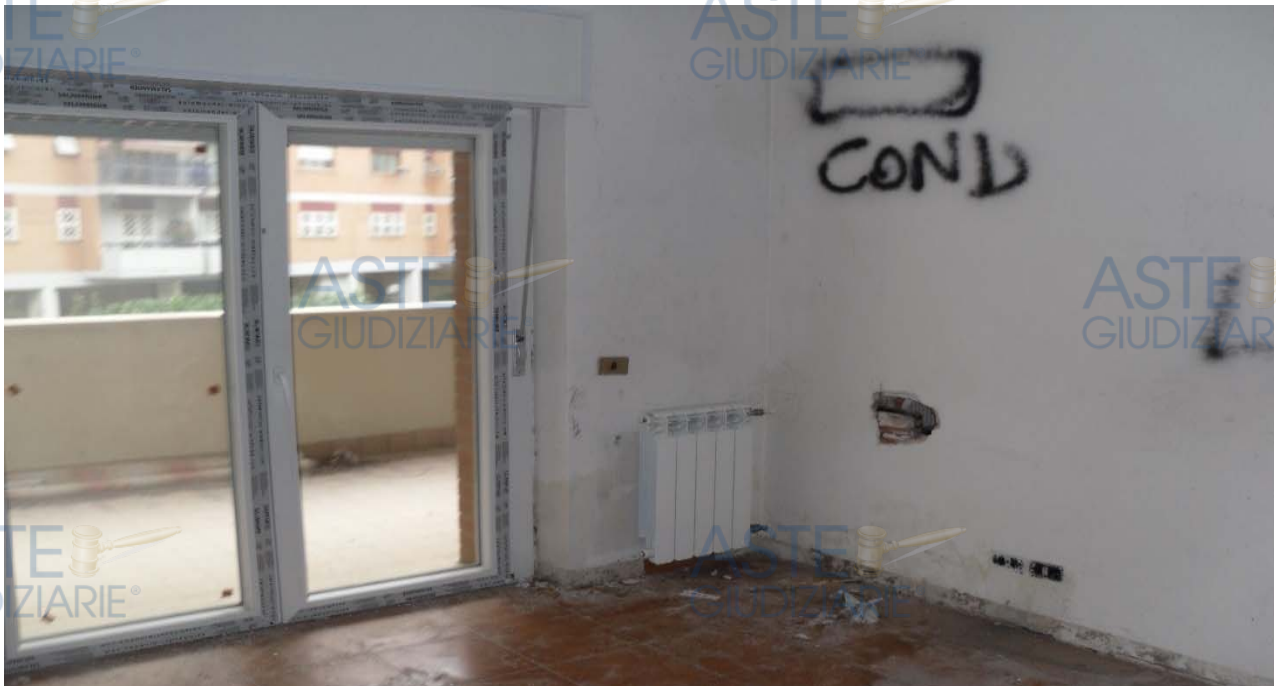
(SOGGIORNO/PRANZO - INTERVENTI DI RISTRUTTURAZIONE NON ULTIMATI)
