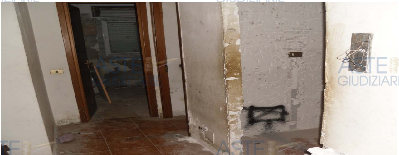
(ZONA DISIMPEGNO - INTERVENTI DI RISTRUTTURAZIONE NON ULTIMATI)
