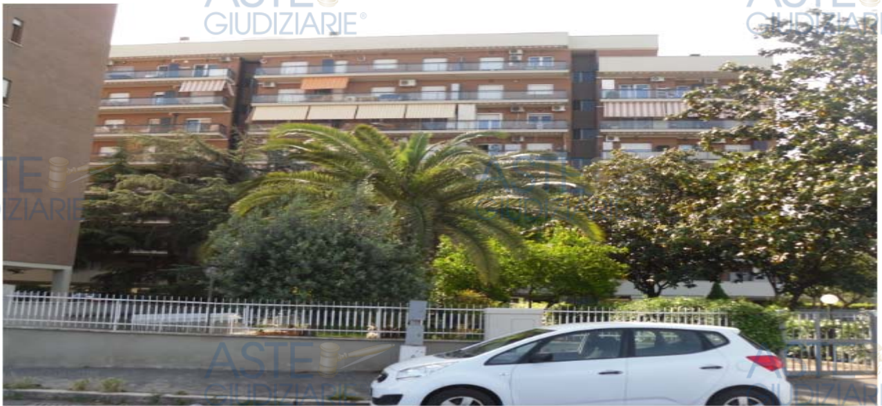
(FOTO ESTERNA - EDIFICIO DI CUI LA PORZIONE IN ESAME È PARTE)
