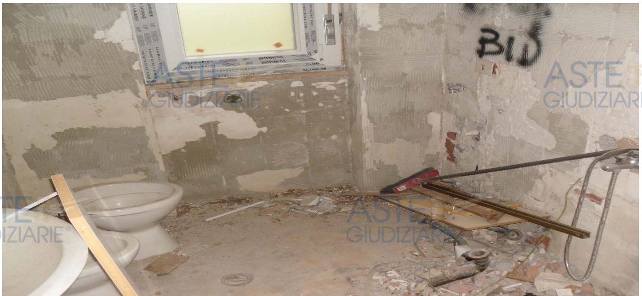
(ZONA BAGNO - INTERVENTI DI RISTRUTTURAZIONE NON ULTIMATI)
