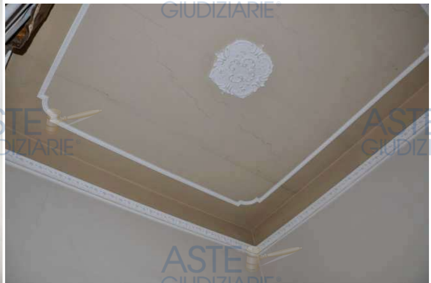
Stucchi sul soffitto del soggiorno
